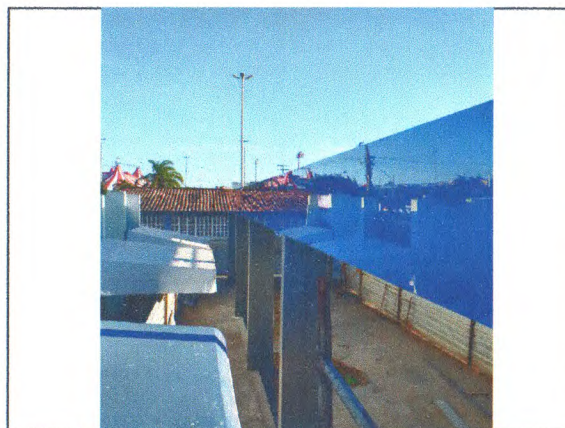
REVESTIMENTO METÁLICO EM ALUCOBOND
