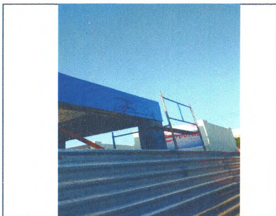
REVESTIMENTO METÁLICO EM ALUCOBOND
