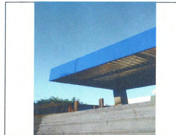
REVESTIMENTO METÁLICO EM ALUCOBOND
