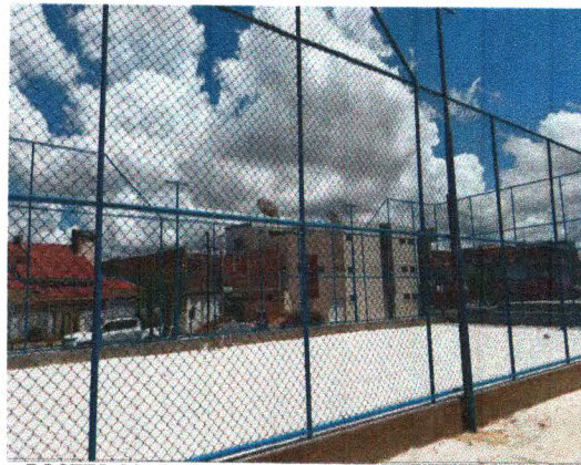
POSTES CONICOS, ALAMBRADO REBOCO, ATERRO
