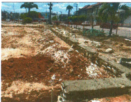
ALVENARIA DE PEDRA
