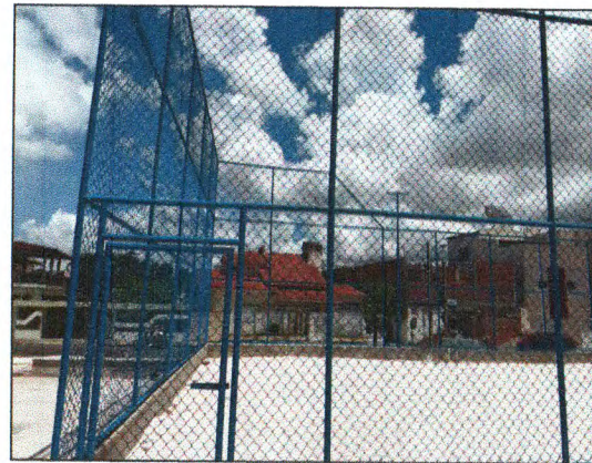
POSTES CONICOS, ALAMBRADO REBOCO, ATERRO
