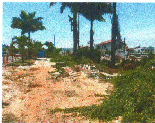
DEMOLIÇÃO E ESCAVAÇÃO
