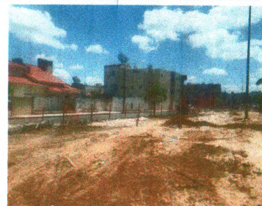
DEMOLIÇÃO E ESCAVAÇÃO
