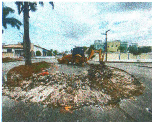
DEMOLIÇÃO DO PAVIMENTO ASFÁLTICO
