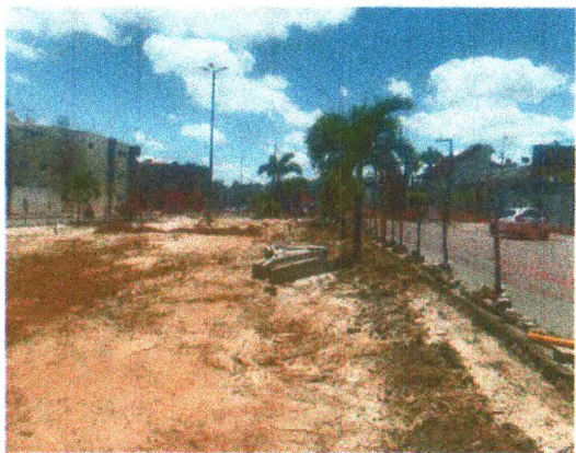
DEMOLIÇÃO E ESCAVAÇÃO
