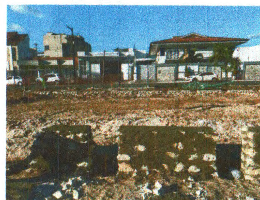
ALVENARIA DE PEDRA
