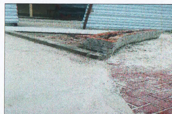
BANCO CONCRETO CANTEIRO 03
