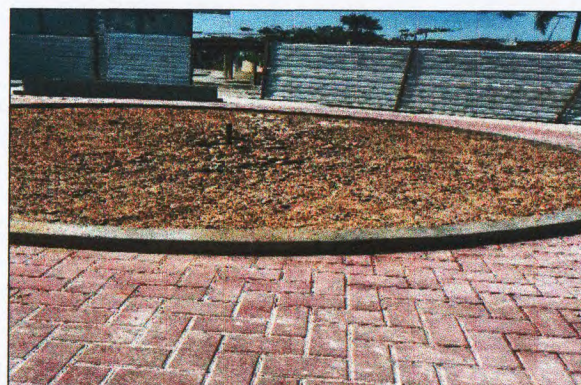
EXECUÇÃO DE PASSEIO INTERTRAVADO CANTEIRO 02
