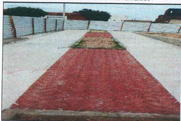
EXECUÇÃO DE PASSEIO INTERTRAVADO PERGOLADO
