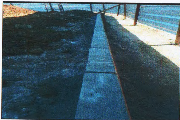
ASSENTAMENTO DE GUIA ÁREA EXTERNA
