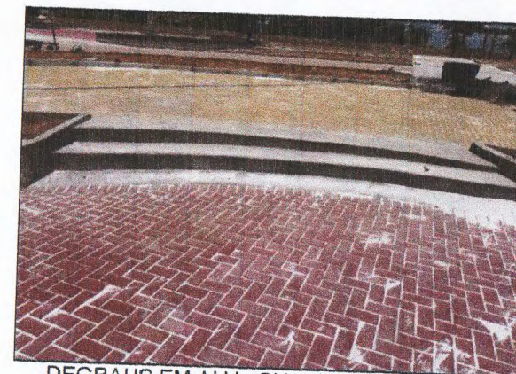
DEGRAUS EM ALV., CHAPISCO E REBOCO
