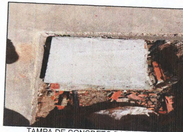
TAMPA DE CONCRETO DAS CAIXAS
