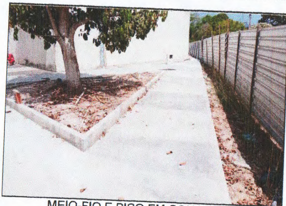
MEIO-FIO E PISO EM CONCRETO
