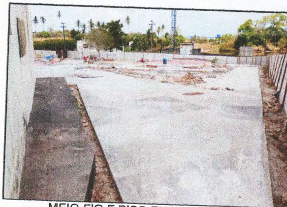
MEIO-FIO E PISO EM CONCRETO
