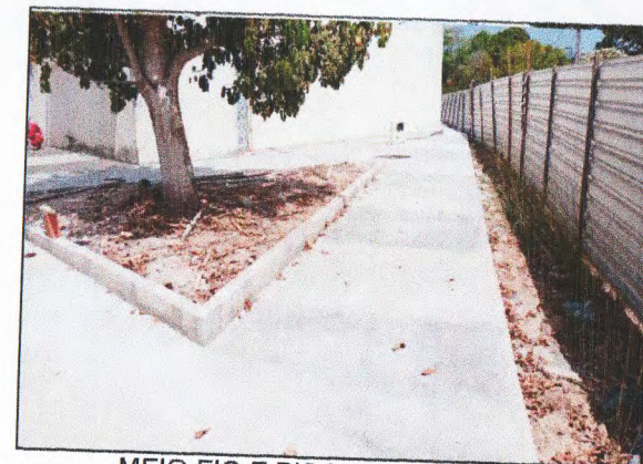
MEIO-FIO E PISO EM CONCRETO
