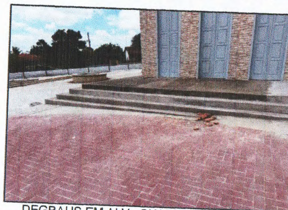
DEGRAUS EM ALV., CHAPISCO E REBOCO
