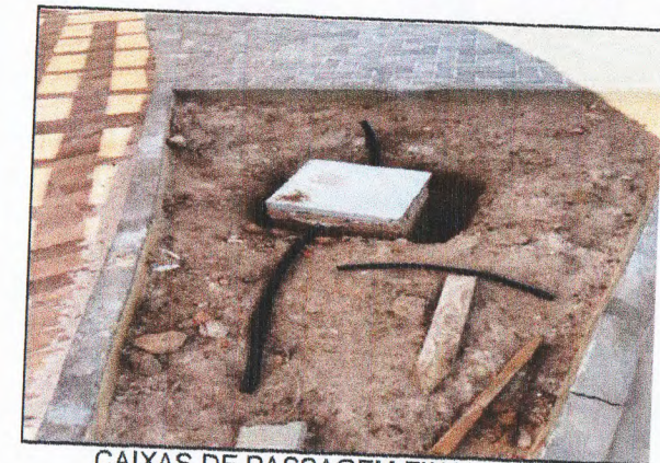
CAIXAS DE PASSAGEM FINALIZADAS
