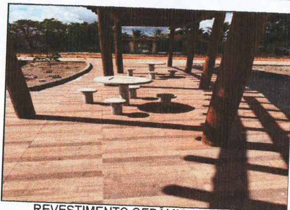
REVESTIMENTO CERÂMICO E MESAS
