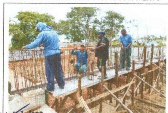
FORMA E AÇO - ESTRUTURAS
