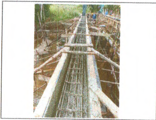
CONCRETAGEM DAS ESTRUTURAS
