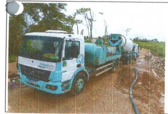
CONCRETAGEM DAS ESTRUTURAS
