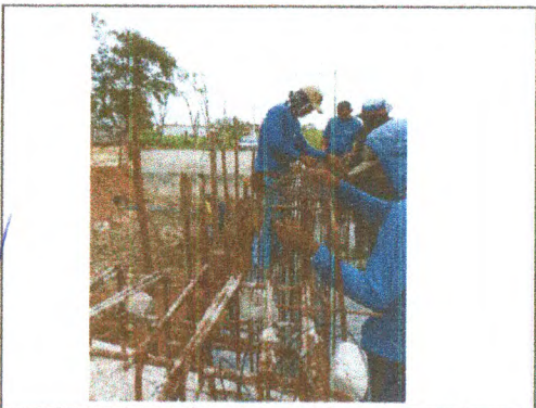
FORMA E AÇO - ESTRUTURAS
