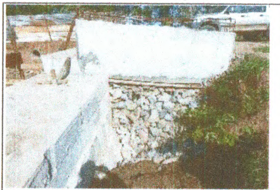
CONCRETO BERÇO, CORTINA E ALAS
