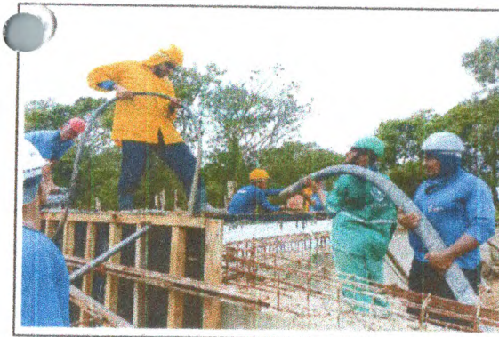
CONCRETAGEM DAS ESTRUTURAS
