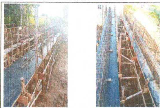
FORMA E AÇO - ESTRUTURAS
