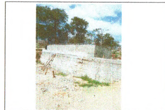
CONCRETO BERÇO E CORTINA
