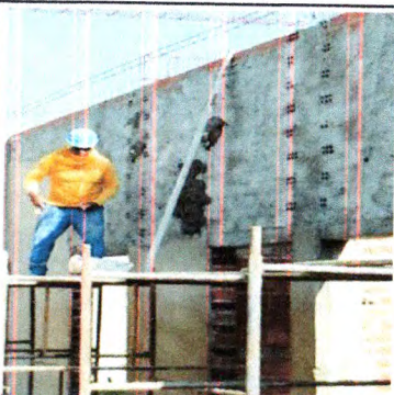
EDIFICAÇÃO: CHAPISCO E REBOCO
