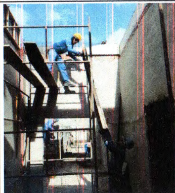
EDIFICAÇÃO: CHAPISCO E REBOCO
