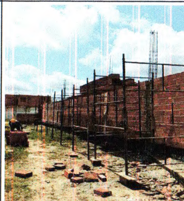
EDIFICAÇÃO: ESTRUTURA E ALVENARIA
