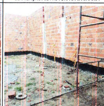
EDIFICAÇÃO: ESTRUTURA E ALVENARIA
