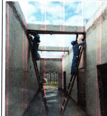
EDIFICAÇÃO: CONTRAPISO E REBOCO
