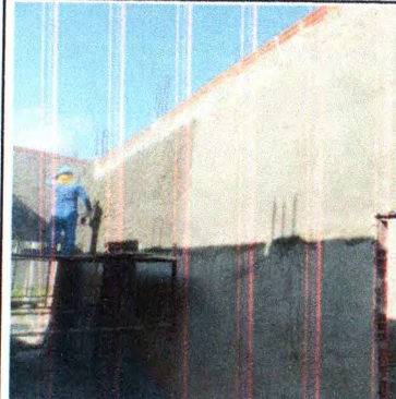
EDIFICAÇÃO: CHAPISCO E REBOCO
