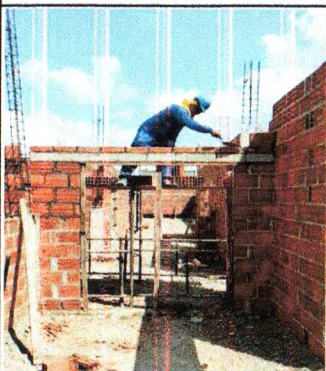
EDIFICAÇÃO: ESTRUTURA E ALVENARIA
