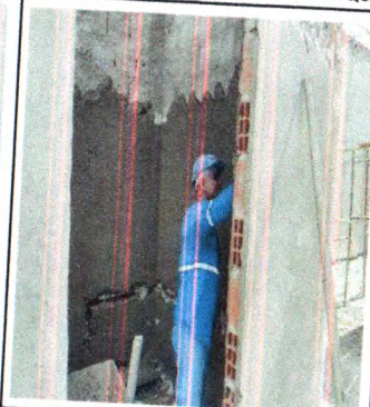
EDIFICAÇÃO: CHAPISCO E REBOCO
