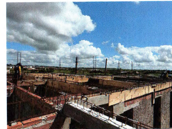
CONCRETAGEM DE VIGAS
