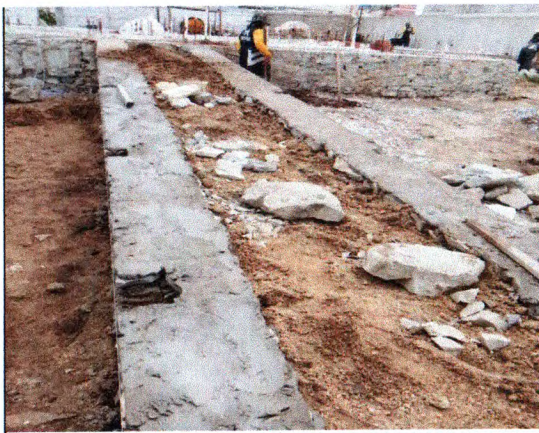
ALVENARIA DE PEDRA E ATERRO
