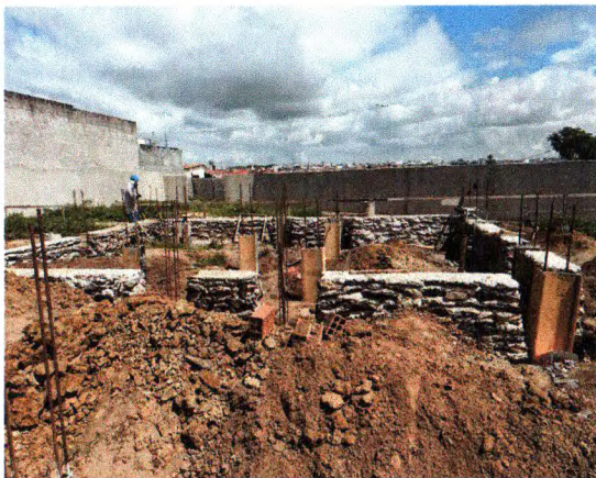
ALVENARIA DE PEDRA
