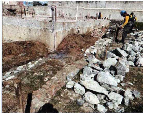
ALVENARIA DE PEDRA
