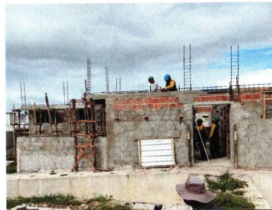
CONCRETAGEM DE VIGAS
