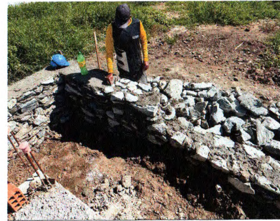
ALVENARIA DE PEDRA
