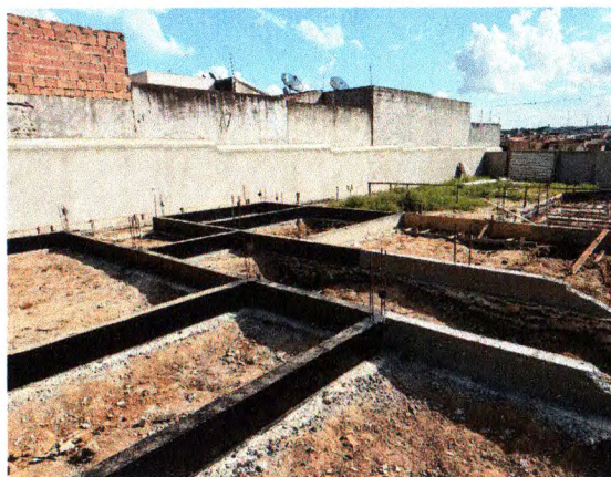
CONCRETAGEM DE VIGAS
