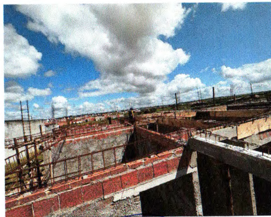
CONCRETAGEM DE VIGAS
