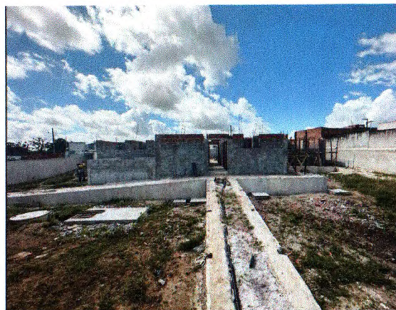
ALVENARIA DE PEDRA E ATERRO
