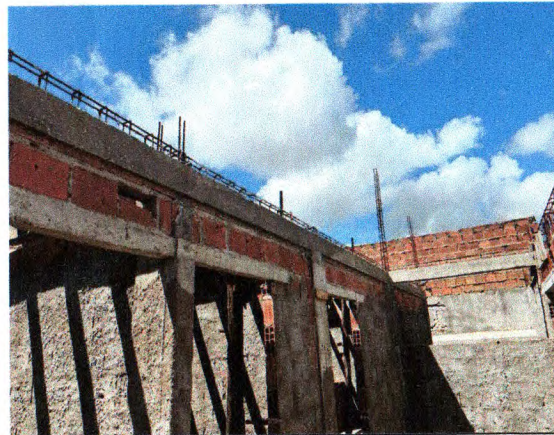
CONCRETAGEM DE VIGAS
