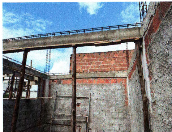
CONCRETAGEM DE VIGAS
