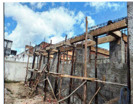
CONCRETAGEM DE VIGAS
