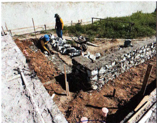
ALVENARIA DE PEDRA
