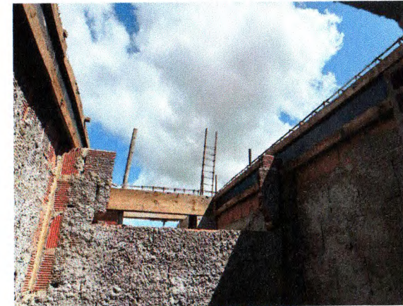
CONCRETAGEM DE VIGAS
