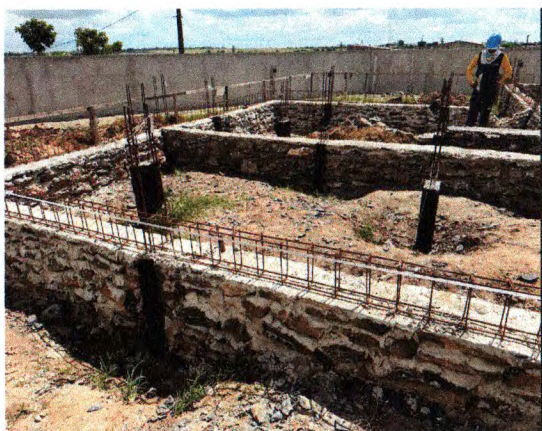
ALVENARIA DE PEDRA
