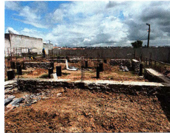
ALVENARIA DE PEDRA
