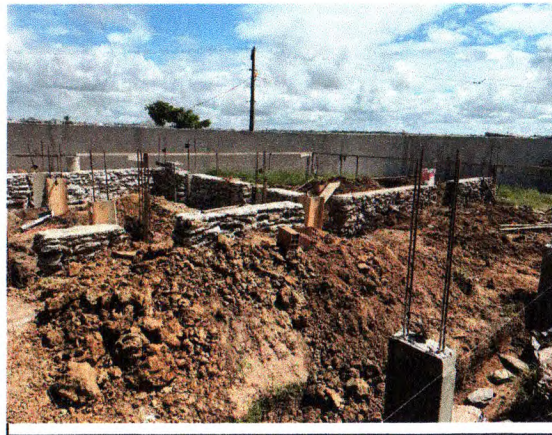
ALVENARIA DE PEDRA
