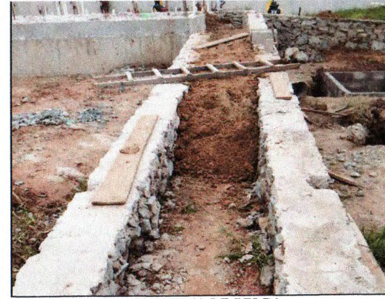
ALVENARIA DE PEDRA
