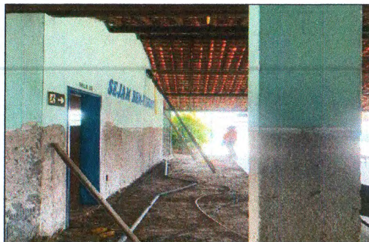
DEMOLIÇÃO MANUAL DE PISO
