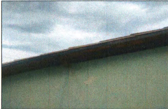
EMASSAMENTO DE BEIRAL
