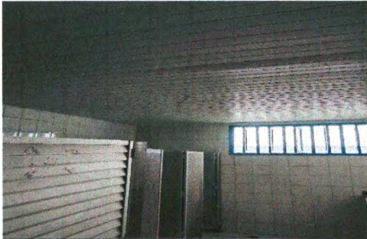
MONTAGEM DE FORRO
