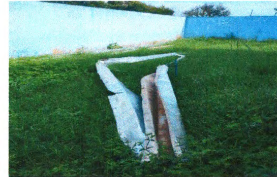
REMOÇÃO DE CALHA
