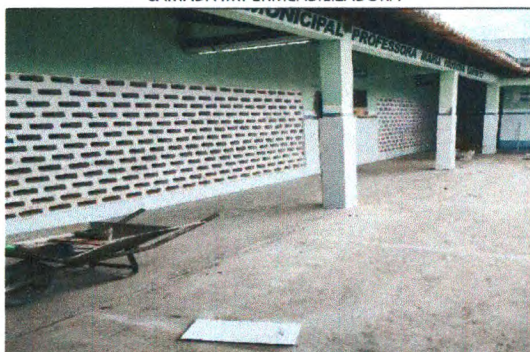
PISO EM CONCRETO SIMPLES
