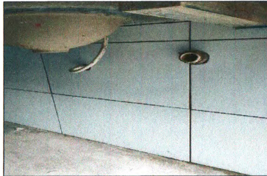
PONTO DE ESGOTO
