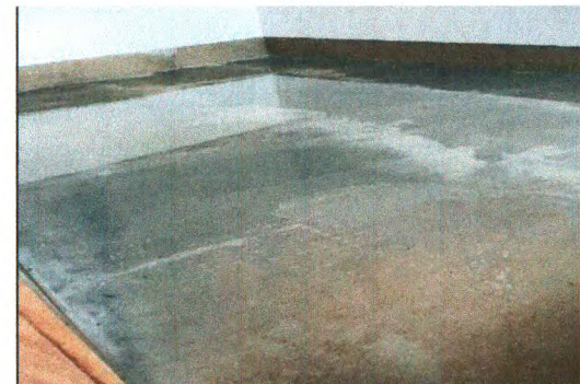
REGULARIZAÇÃO DE BASE
