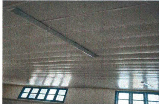
MONTAGEM DE FORRO
