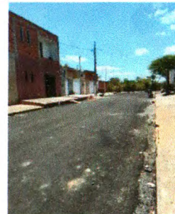
RECAPEAMENTO ASFÁLTICO
