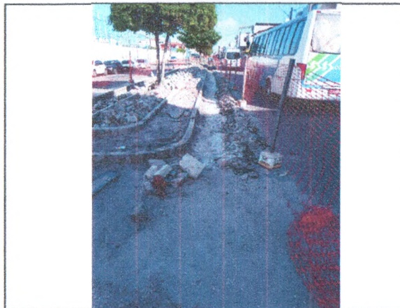
DEMOLIÇÃO DE PAVIMENTAÇÃO EM PARALELEPIPEDO; CORTE DO ASFALTO; ASSENTAMENTO DE MEIO-FIO
