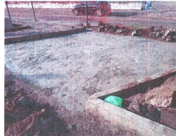
REPOSIÇÃO DE PAVIMENTAÇÃO EM PARALELEPIPEDO; ASSENTAMENTO DE MEIO-FIO
