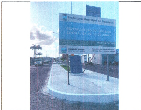
PLACA DA OBRA; MARCO INAUGURAL; PISO EM CONCRETO DESEMPOLADO; PINTURA MEIO-FIO
