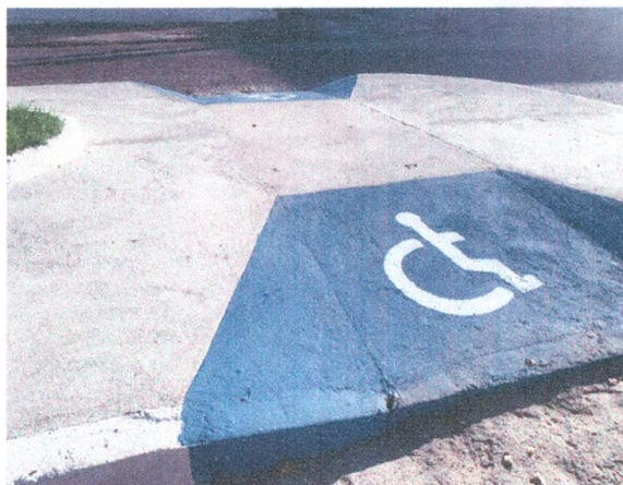
PISO EM CONCRETO DESEMPOLADO; PINTURA DE RAMPAS PARA ACESSO DE DEFICIENTES
