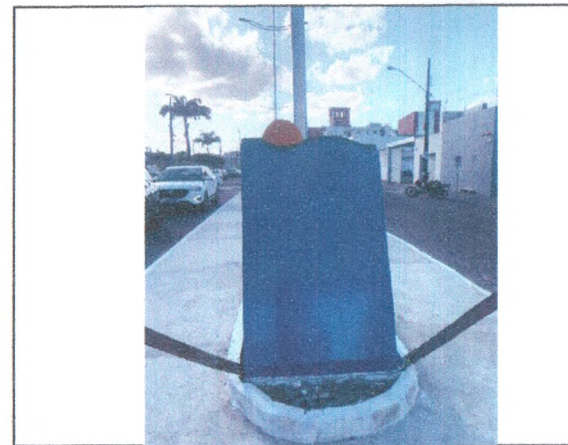
MARCO INAUGURAL; PISO EM CONCRETO DESEMPOLADO; PINTURA MEIO-FIO
