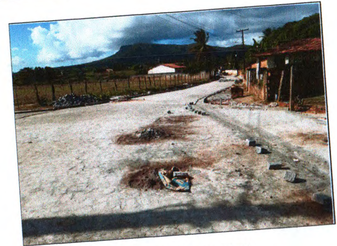
PAVIMENTAÇÃO DO TRECHO 01
