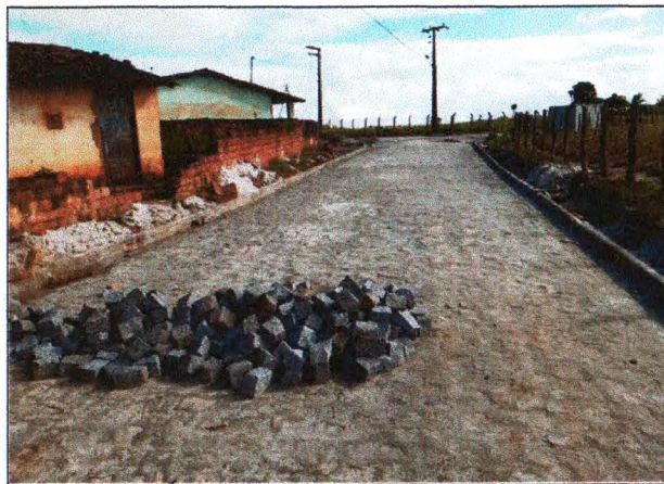
PAVIMENTAÇÃO DO TRECHO 01
