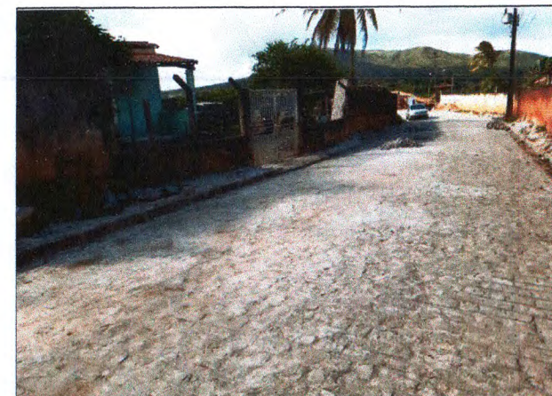
PAVIMENTAÇÃO DO TRECHO 01
