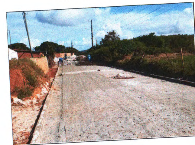
PAVIMENTAÇÃO DO TRECHO 01
