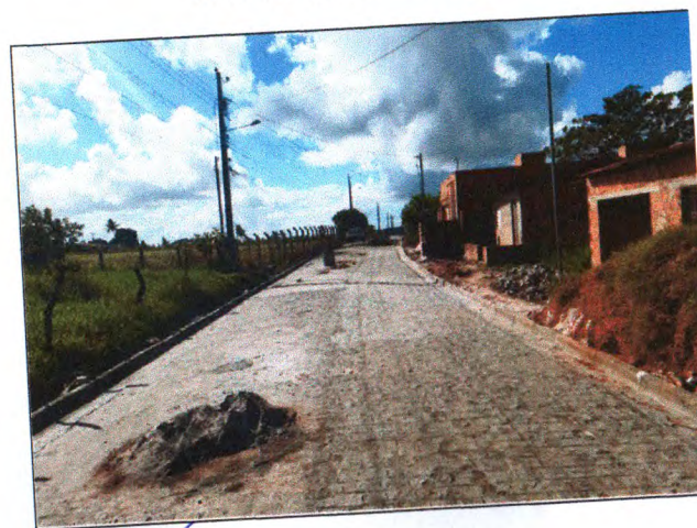
PAVIMENTAÇÃO DO TRECHO 01
