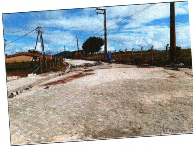
PAVIMENTAÇÃO DO TRECHO 01
