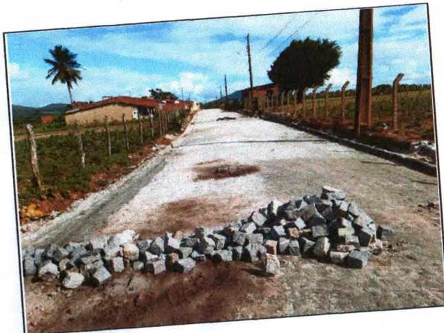
PAVIMENTAÇÃO DO TRECHO 01
