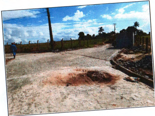
PAVIMENTAÇÃO DO TRECHO 01
