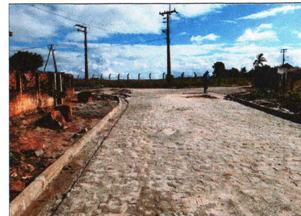
PAVIMENTAÇÃO DO TRECHO 01
