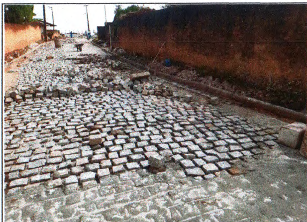
PAVIMENTAÇÃO DO TRECHO 01
