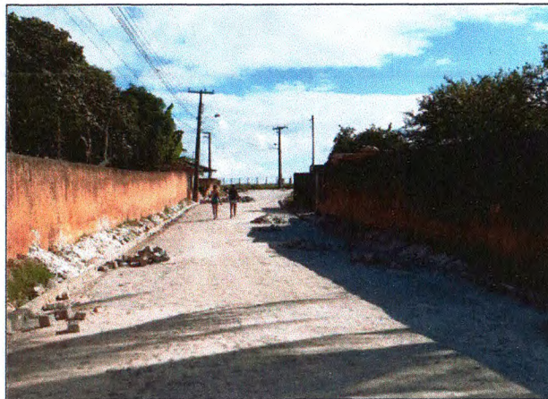
PAVIMENTAÇÃO DO TRECHO 01
