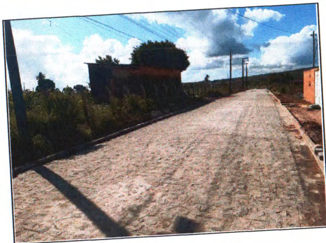
PAVIMENTAÇÃO DO TRECHO 01
