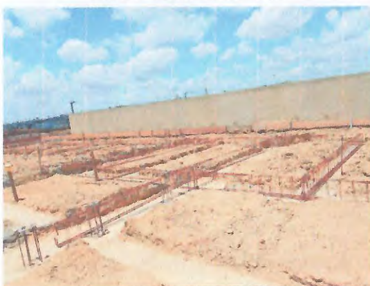
LOCAÇÃO DAS VIGAS BALDRAMES; FERRAGEM; CONCRETO MAGRO
