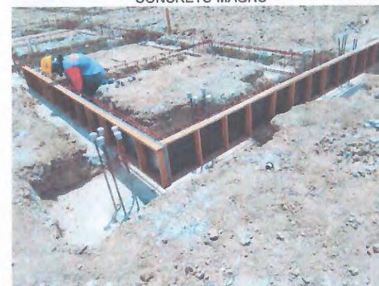
EXECUÇÃO DE FORMAS DAS VIGAS BALDRAMES
