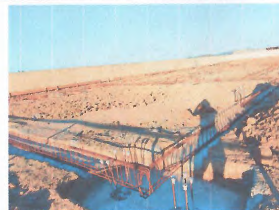
LOCAÇÃO DAS VIGAS BALDRAMES; FERRAGEM; CONCRETO MAGRO
