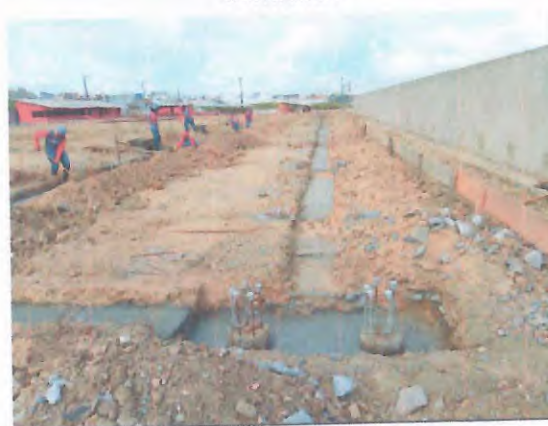
ESCAVAÇÃO; CONCRETO MAGRO
