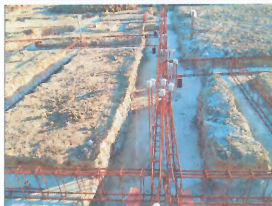
LOCAÇÃO DAS VIGAS BALDRAMES; FERRAGEM; CONCRETO MAGRO
