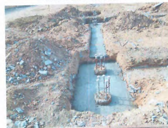
ESCAVAÇÃO; CONCRETO MAGRO
