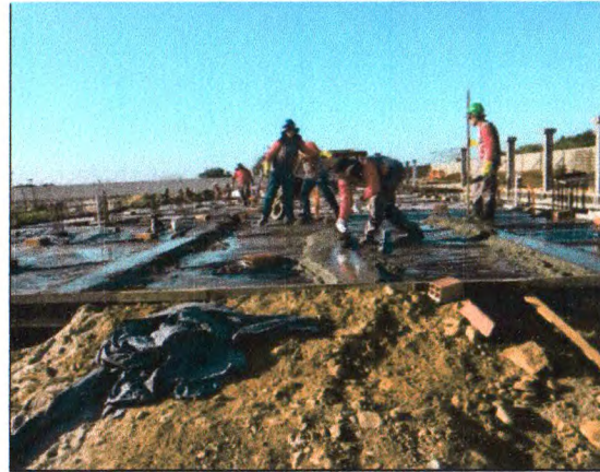
ATERRO; EXECUÇÃO DA CAMADA IMPERMEABILIZADORA NO BLOCO C
