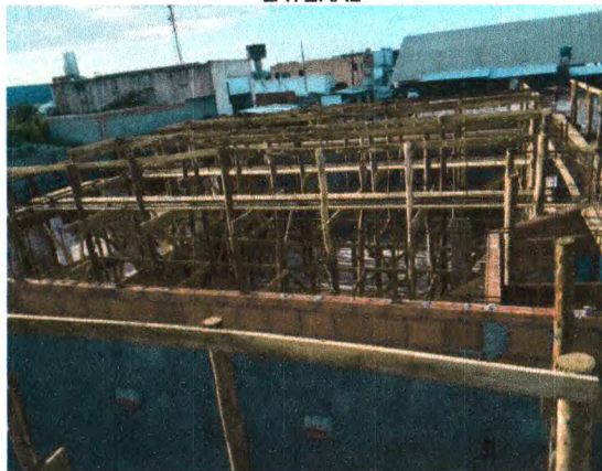
MONTAGEM DAS FORMAS E FERRAGENS DAS VIGAS DO BLOCO B; CHAPISCO NAS PAREDES DO BLOCO B;
