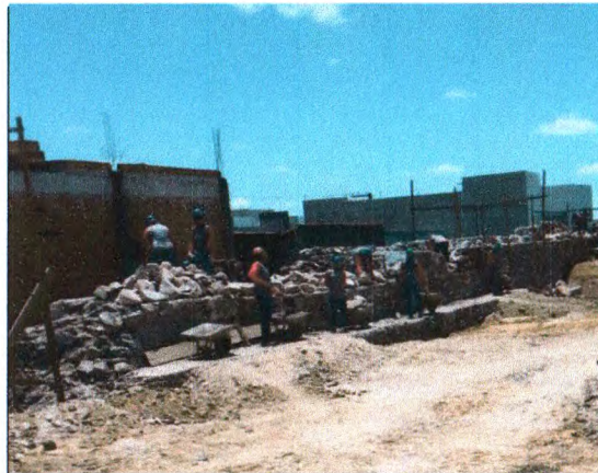
ASSENTAMENTO DA ALVENARIA DE PEDRA NO MURO LATERAL
