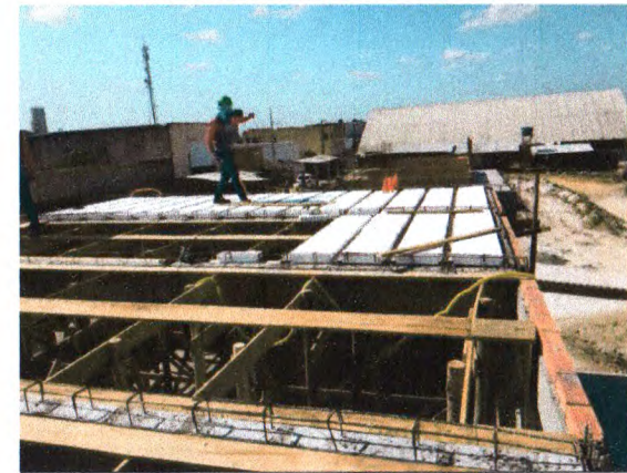
EXECUÇÃO DA LAJE DO BLOCO B
