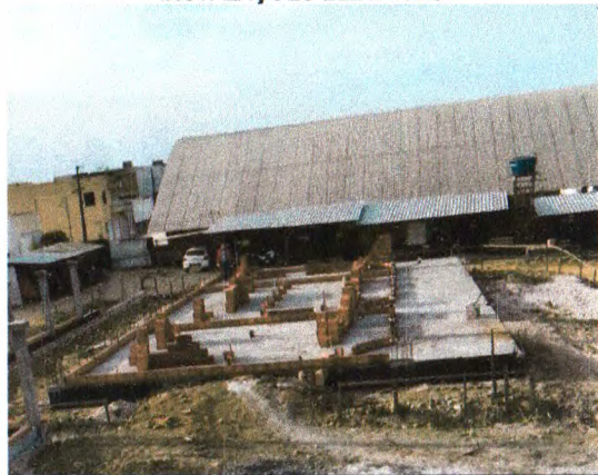
EXECUÇÃO DA ALVENARIA DE BLOCO CERÂMICO NO BLOCO C
