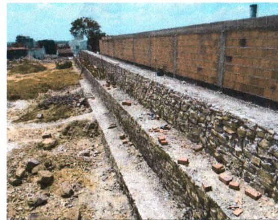
ALVENARIA CERÂMICA: CINTAMENTO INFERIOR; PILARES CONCRETADOS NO MURO LATERAL
