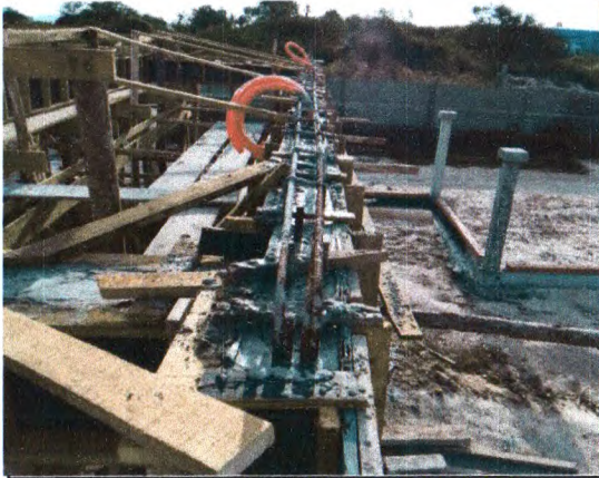
CONCRETAGEM DAS VIGAS DO BLOCO B; INSTALAÇÕES ELÉTRICAS
