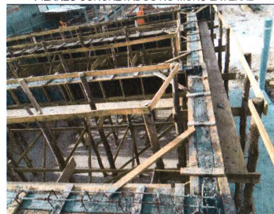
CONCRETAGEM DAS VIGAS DO BLOCO B
