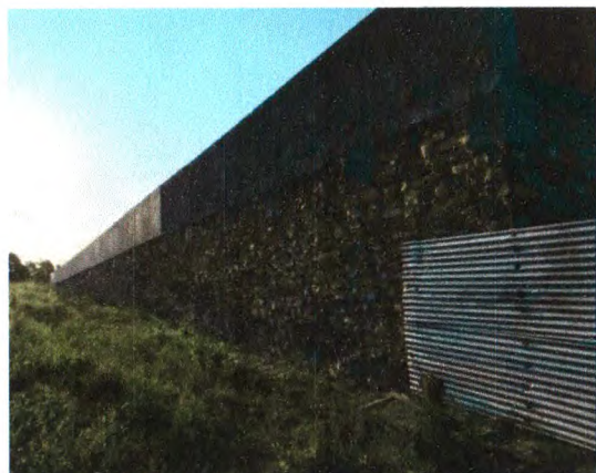
CONTENÇÃO EM ALVENARIA DE PEDRA; ALVENARIA CERÂMICA; CINTAMENTO INFERIOR; PILARES CONCRETADOS; CHAPISCO E REBOCO NO MURO LATERAL
