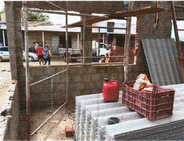
CHAPISCO INTERNO, TELHAS PARA A COBERTURA
