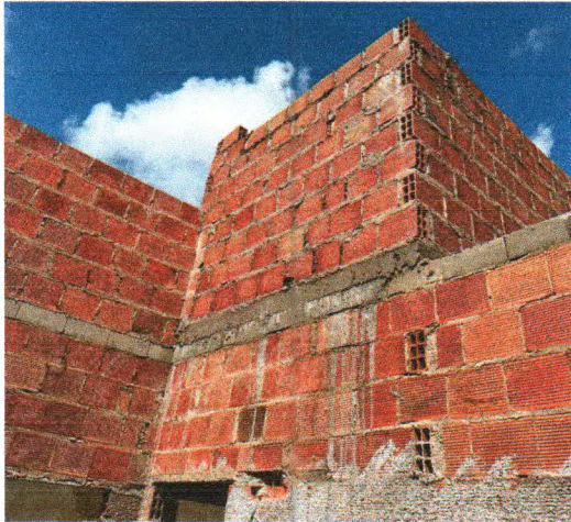
ALVENARIA E CINTAMENTO
