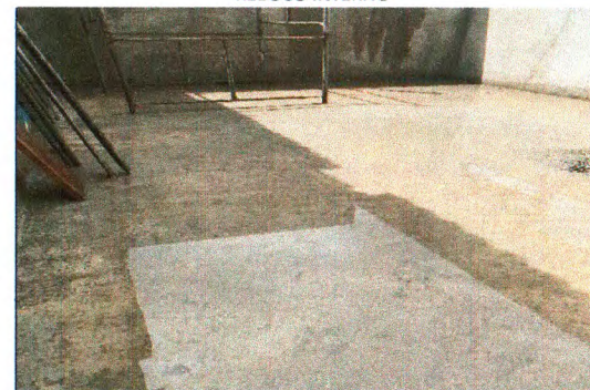
REGULARIZAÇÃO DE BASE
