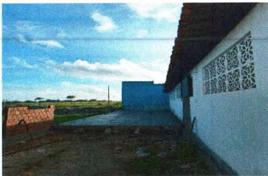
REGULARIZAÇÃO DE BASE
