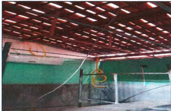
DEMOLIÇÃO DE MADEIRAMENTO
