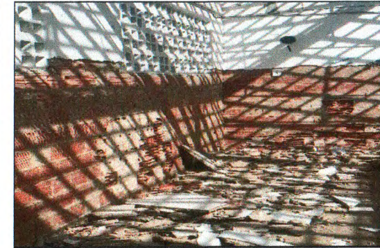
DEMOLIÇÃO DE REBOCO
