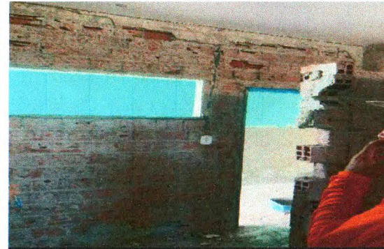
DEMOLIÇÃO DE REBOCO
