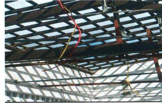
REMOÇÃO DE FORRO
