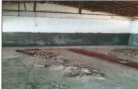
REMOÇÃO DE FORRO
