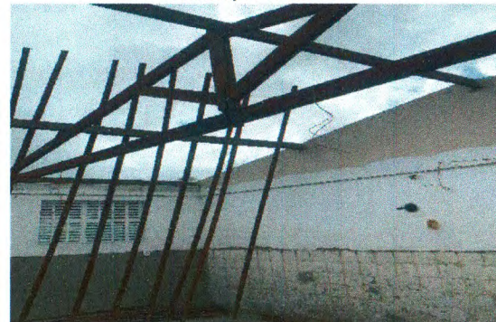
REMOÇÃO DE TESOURA
