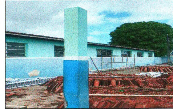
REMOÇÃO DE TELHAMENTO
