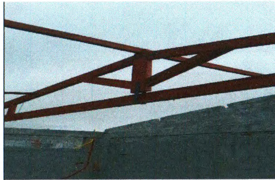
FABRICAÇÃO E INSTALAÇÃO DE TESOURA
