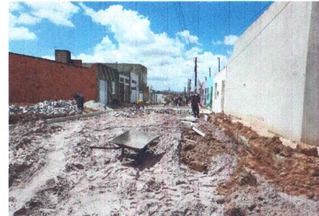
RUA JOSÉ LIMA - REGULARIZAÇÃO; COLCHÃO DE AREIA; ASSENTAMENTO MEIO-FIO DE CONCRETO
