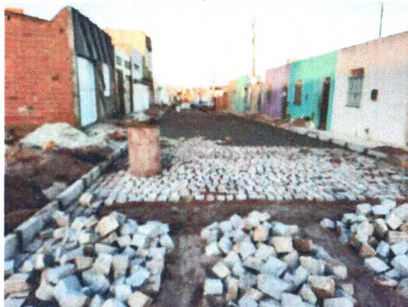
RUA JOSÉ LIMA - REGULARIZAÇÃO; COLCHÃO DE AREIA; ASSENTAMENTO MEIO-FIO DE CONCRETO E PARALELEPÍPEDO; DRENAGEM SUPERFICIAL
