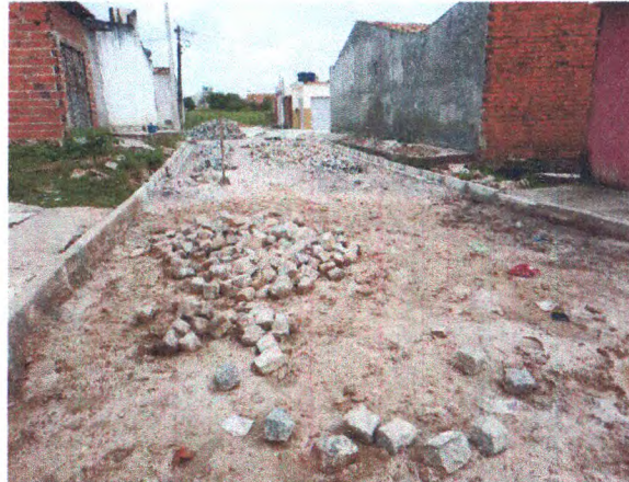
RUA JOSÉ ERALDO SANTOS - ASSENTAMENTO MEIO-FIO E PARALELEPÍPEDO; DRENAGEM SUPERFICIAL
