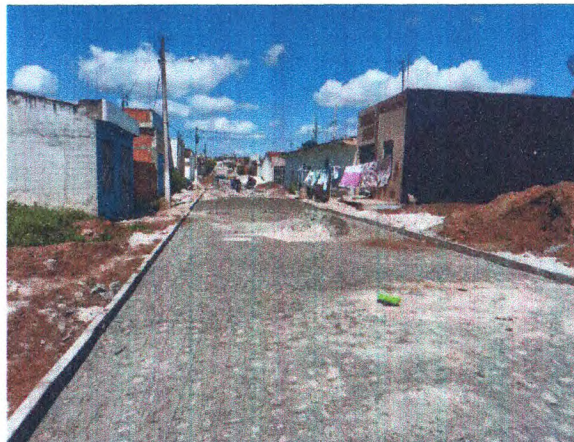
RUA FRANCISCA XAVIER NUNES - ASSENTAMENTO MEIO-FIO E PARALELEPÍPEDO; DRENAGEM
