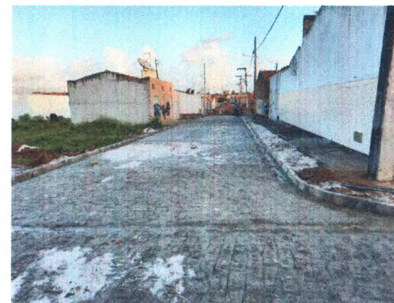
RUA JOSÉ VINCENTE DE ALMEIDA - REGULARIZAÇÃO DO TERRENO; COLCHÃO DE AREIA
