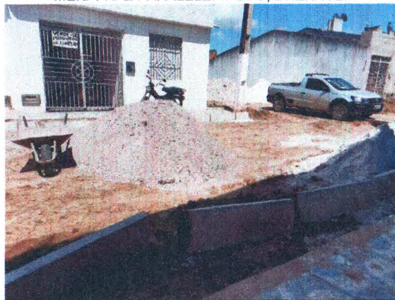
RUA JOSÉ LIMA - REGULARIZAÇÃO; COLCHÃO DE AREIA; ASSENTAMENTO MEIO-FIO DE CONCRETO
