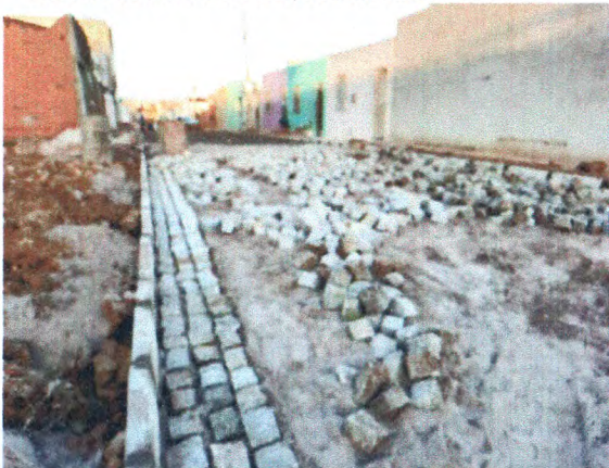
RUA JOSÉ LIMA - REGULARIZAÇÃO; COLCHÃO DE AREIA; ASSENTAMENTO MEIO-FIO DE CONCRETO E PARALELEPÍPEDO; DRENAGEM SUPERFICIAL
