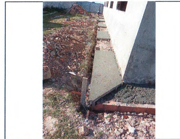
REBOCO EXTERNO; PISO EM CONCRETO DESEMPOLADO
