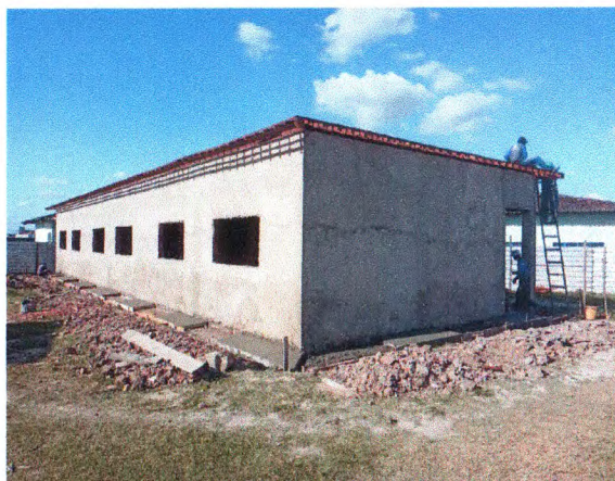
REBOCO EXTERNO; MADEIRAMENTO DO TELhado; PISO EM CONCRETO DESEMPOLADO
