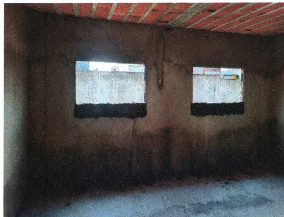
REBOCO INTERNO; LAJE PRÉ-MOLDADA
