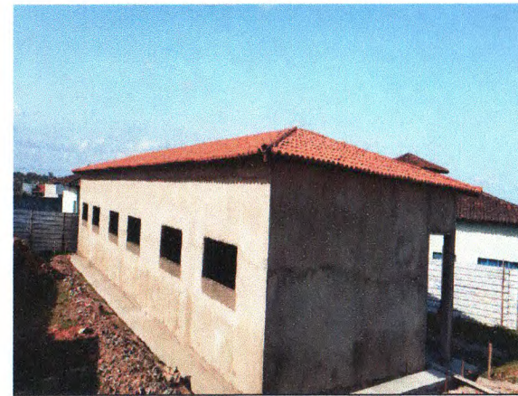
REBOCO EXTERNO; COBERTURA COM TELHA CERÂMICA; PISO EM CONCRETO DESEMPOLADO
