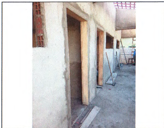
REBOCO INTERNO; CAIXÃO EM MADEIRA DAS PORTAS
