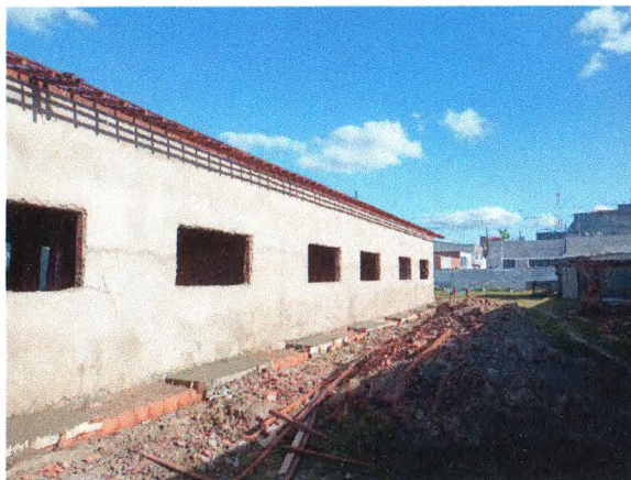
REBOCO EXTERNO; MADEIRAMENTO DO TELHADO
