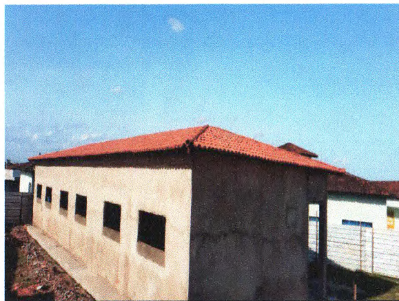
REBOCO EXTERNO; COBERTURA COM TELHA CERÂMICA; PISO EM CONCRETO DESEMPOLADO
