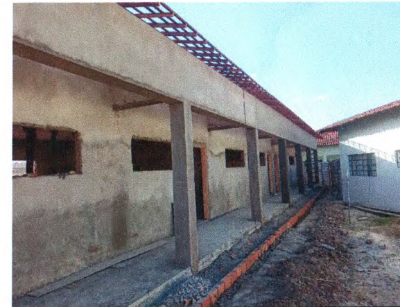
REBOCO INTERNO E EXTERNO; MADEIRAMENTO DO TELHADO
