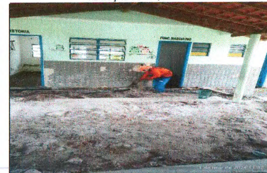
DEMOLIÇÃO PISO PASSEIO ENTRE BLOCOS
