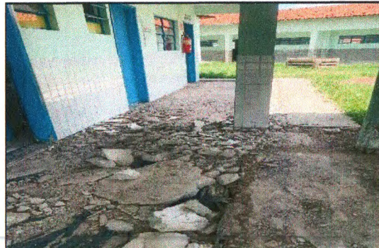
DEMOLIÇÃO DE PISO CIMENTADO ADM
