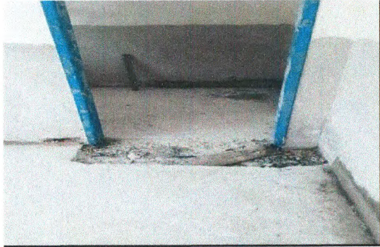
DEMOLIÇÃO PISO ARQUIVO
