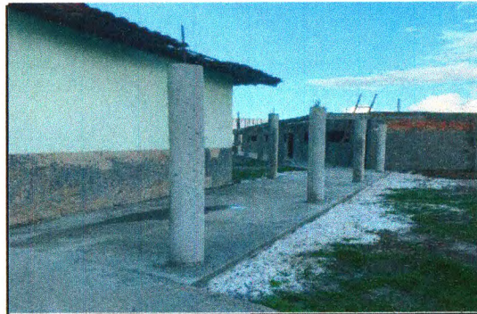
REGULARIZAÇÃO DE BASE
