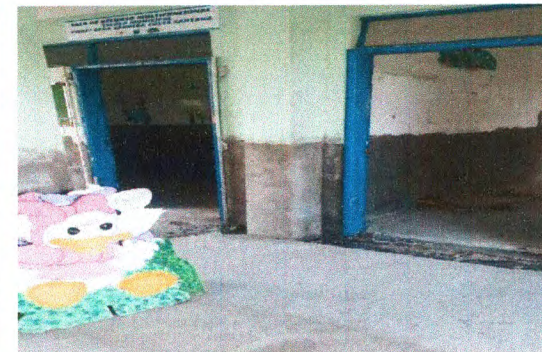
REMOÇÃO DE ESQUADRIAS
