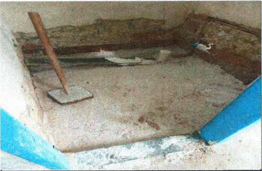
DEMOLIÇÃO PISO WC ADM
