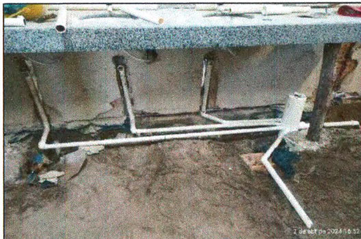
PONTO DE ESGOTO
