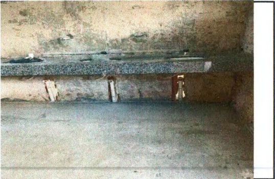
REGULARIZAÇÃO DE BASE
