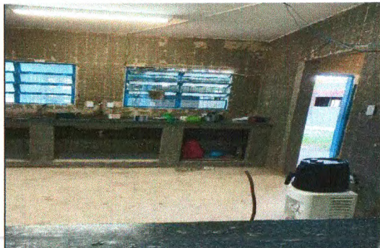
DEMOLIÇÃO DE REVESTIMENTO CERÂMICO
