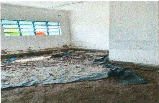
DEMOLIÇÃO PISO SECRETARIA
