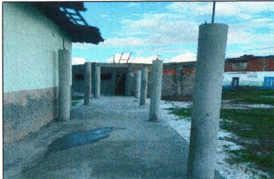
REGULARIZAÇÃO DE BASE
