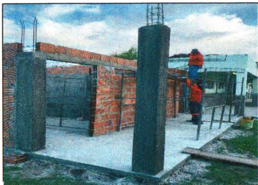
REGULARIZAÇÃO DE BASE
