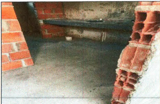
REGULARIZAÇÃO DE BASE
