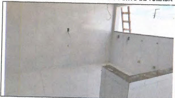
REVESTIMENTO CERAMICO INTERNO E PONTO DE TOMADA
