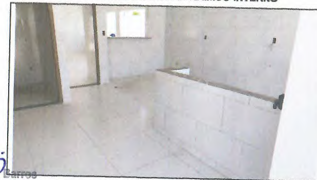
PISO E REVESTIMENTO CERAMICO INTERNO
