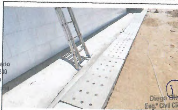
CALHA COM GRELHA EM CONCRETO E PISO CIMENTADO
