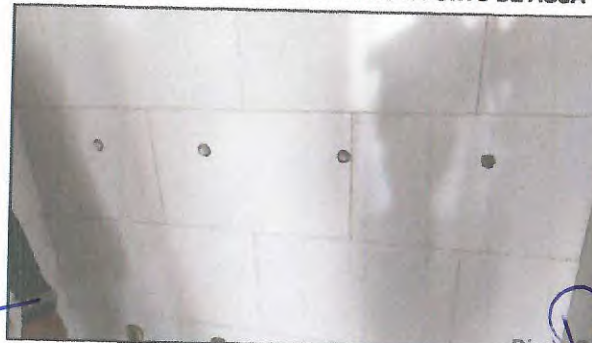
REVESTIMENTO CERAMICO INTERNO E PONTO DE ÁGUA
