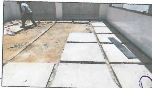
PISO EM CONCRETO SIMPLES
