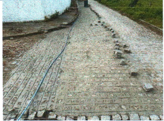
RUA DO OVO E MEIO-FIO INSTALADO
