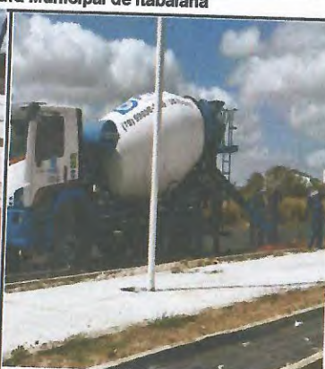
CONCRETAGEM DA CICLOVIA COM LONA PLÁSTICA E TELA
