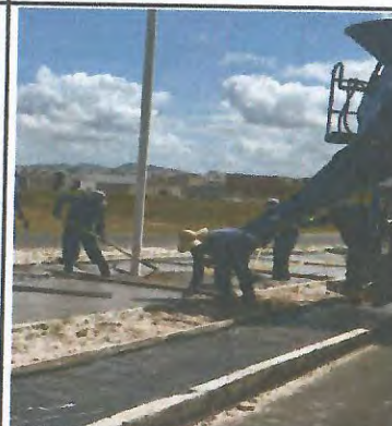
PAVIMENTAÇÃO EM CONCRETO COM LONA PLÁSTICA E FORMA DE MADEIRA
