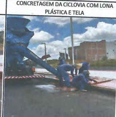
CONCRETAGEM DA CICLOVIA COM LONA PLÁSTICA E TELA
