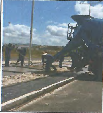
PAVIMENTAÇÃO EM CONCRETO COM LONA PLÁSTICA E FORMA DE MADEIRA
