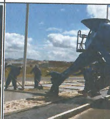
PAVIMENTAÇÃO EM CONCRETO COM LONA PLÁSTICA E FORMA DE MADEIRA
