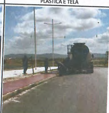
CONCRETAGEM DA CICLOVIA COM LONA PLÁSTICA E TELA
