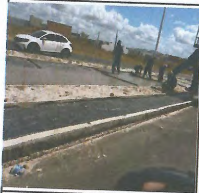
PAVIMENTAÇÃO EM CONCRETO COM LONA PLÁSTICA E FORMA DE MADEIRA
