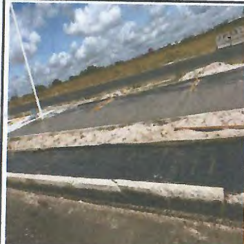
CONCRETAGEM DA CICLOVIA COM LONA PLÁSTICA E TELA + PAVIMENTAÇÃO EM CONCRETO COM LONA PLÁSTICA E FORMA DE MADEIRA
