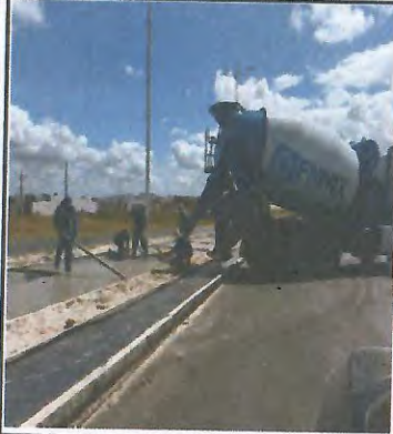
PAVIMENTAÇÃO EM CONCRETO COM LONA PLÁSTICA E FORMA DE MADEIRA
