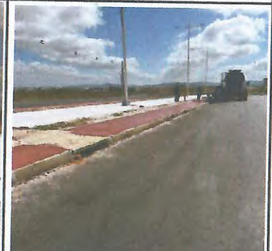
PAVIMENTAÇÃO EM CONCRETO COM LONA PLÁSTICA E FORMA DE MADEIRA
