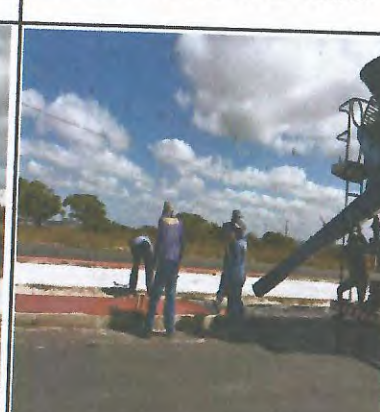
CONCRETAGEM DA CICLOVIA COM LONA PLÁSTICA E TELA
