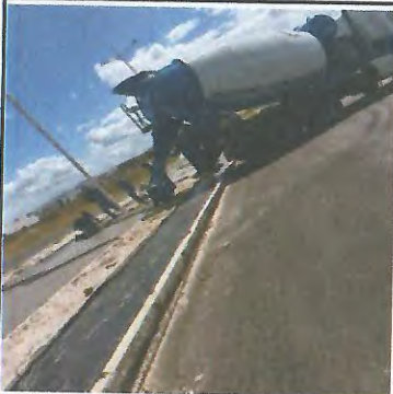
CONCRETAGEM DA CICLOVIA COM LONA PLÁSTICA E TELA + PAVIMENTAÇÃO EM CONCRETO COM LONA PLÁSTICA E FORMA DE MADEIRA
