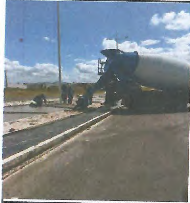
PAVIMENTAÇÃO EM CONCRETO COM LONA PLÁSTICA E FORMA DE MADEIRA
