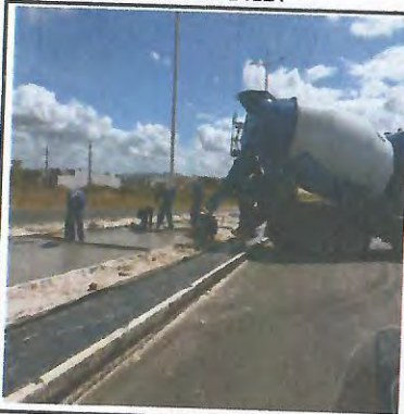
PAVIMENTAÇÃO EM CONCRETO COM LONA PLÁSTICA E FORMA DE MADEIRA
