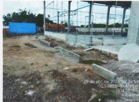
ASSENTAMENTO DE MEIO-FIO
