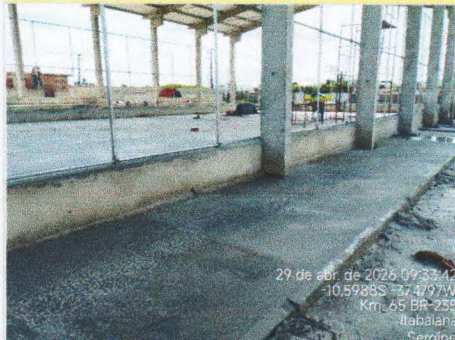
PISO EM CONCRETO SIMPLES - PAVIMENTAÇÃO EXTERNA
