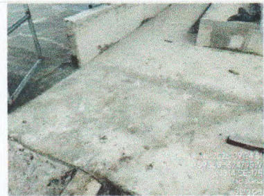
PISO EM CONCRETO SIMPLES
