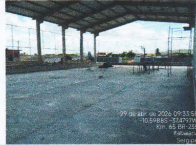
EXECUÇÃO DE CAMADA IMPERMEABILIZADORA
