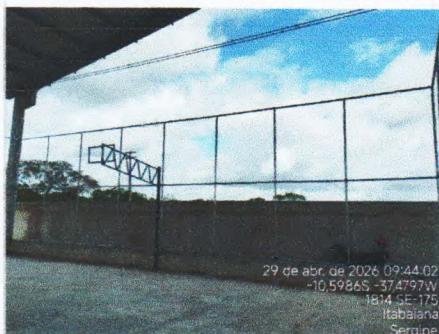
ESTRUTURA METÁLICA - TRAVES DE BASQUETE
