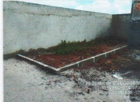
ASSENTAMENTO DE MEIO-FIO
