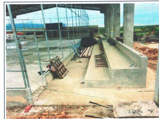
PISO EM CONCRETO
