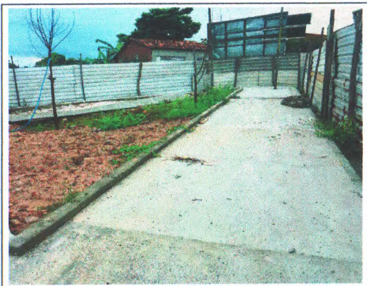
PISO EM CONCRETO
