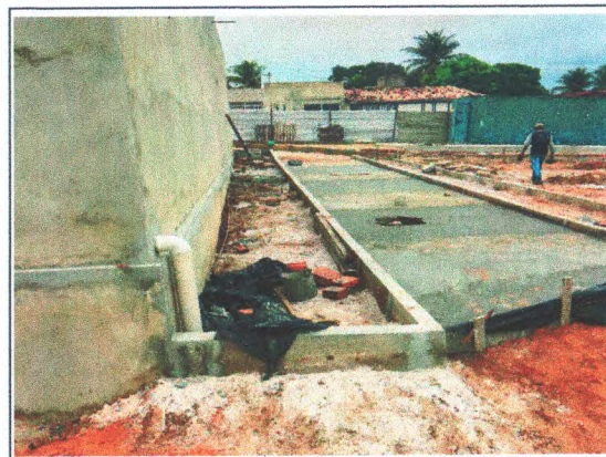
PISO EM CONCRETO
