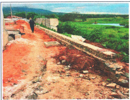
CAIXA DE PASSAGEM
