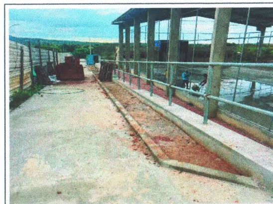
PISO EM CONCRETO
