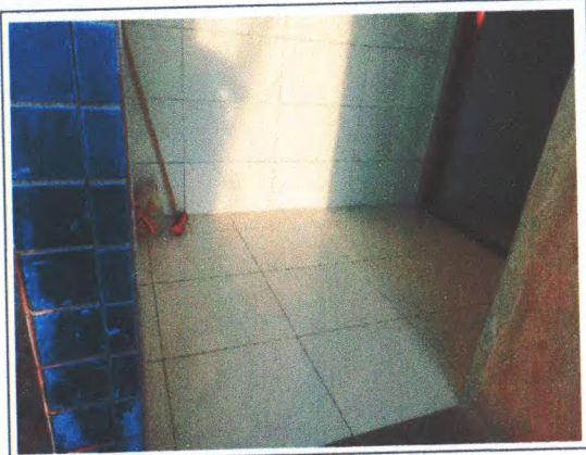
REVESTIMENTO CERÂMICO PISO
