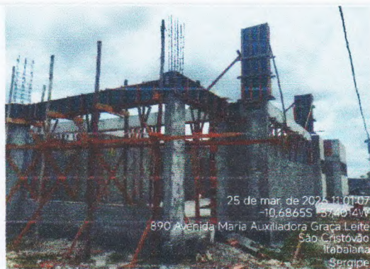
MONTAGEM DE FORMA E CONCRETAGEM PILARES
