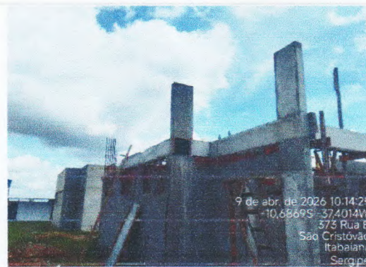
MONTAGEM DE FORMA E CONCRETAGEM PILARES
