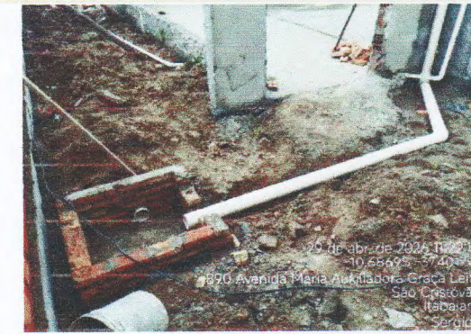
DRENAGEM PLUVIAL - TUBOS
