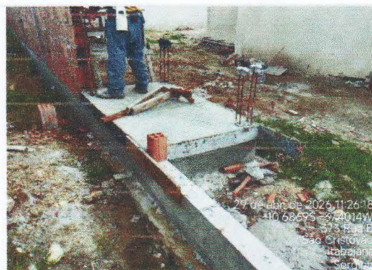
FUNDAÇÕES - ABRIGO DE GÁS
