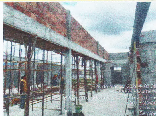
ALVENARIA DE VEDAÇÃO EM BLOCO CERÂMICO
