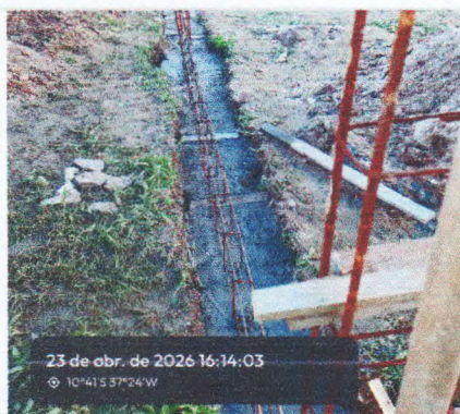
MOVIMENTO DE TERRA - ABRIGO DE GÁS
