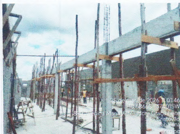
MONTAGEM DE FORMA E CONCRETAGEM VIGAS
