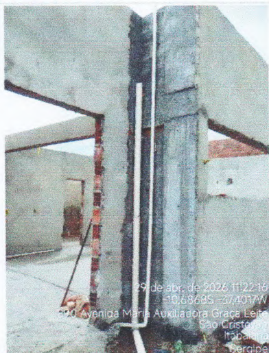
DRENAGEM PLUVIAL - TUBOS
