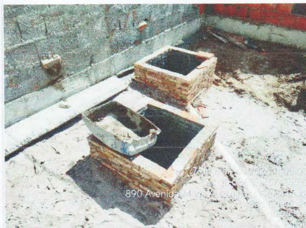
DRENAGEM PLUVIAL - CAIXAS
