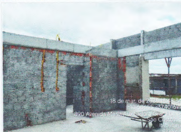
VERGAS EM CONCRETO ARMADO
