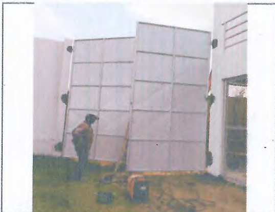
FECHAMENTO EM CHAPA DE FERRO; PINTURA DE ESQUADRIA METÁLICA
