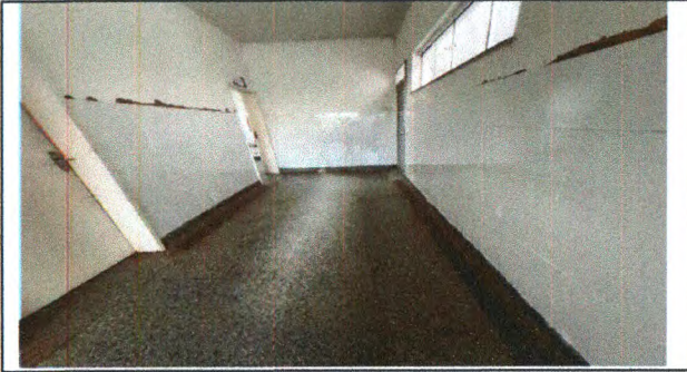
EMASSAMENTO DE PAREDES
