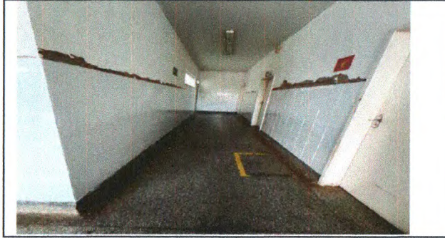
EMASSAMENTO DE PAREDES
