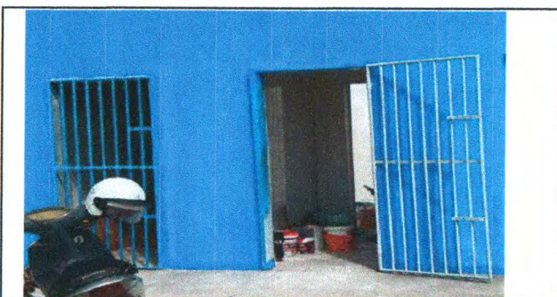
EMASSAMENTO E PINTURA EM SUPERFÍCIES METÁLICAS
