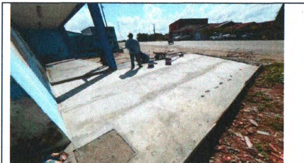
CHAPISCO, REBOCO E EXECUÇÃO DE CALÇADA
