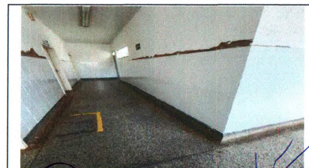
DEMOLIÇÃO DE PISO CERAMICO E REVESTIMENTO CERÂMICO
