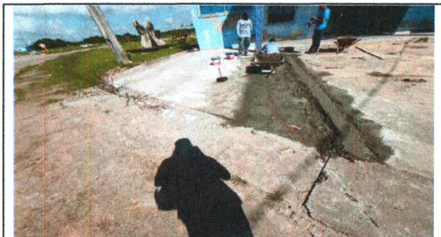
CHAPISCO, REBOCO E EXECUÇÃO DE CALÇADA
