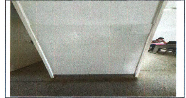
EMASSAMENTO DE PAREDES
