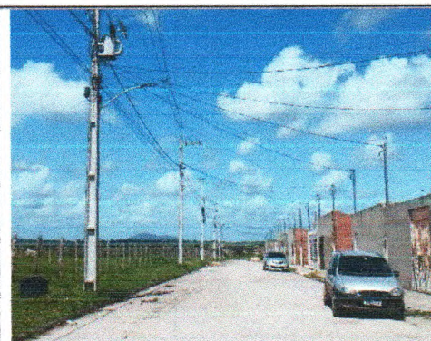
RUA BELARMINO JOSÉ DOS SANTOS – RUA P
