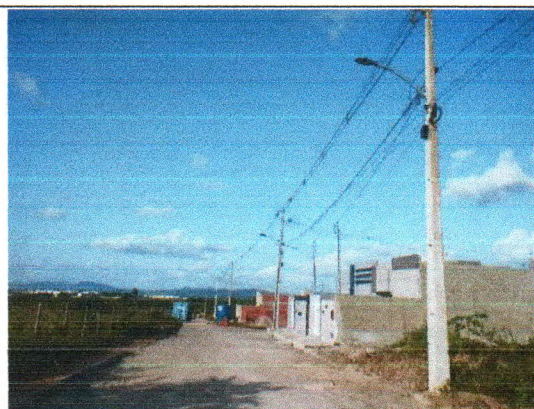
RUA PROJETADA Q (PRÓXIMO TRAVESSA SÃO LUIZ)
