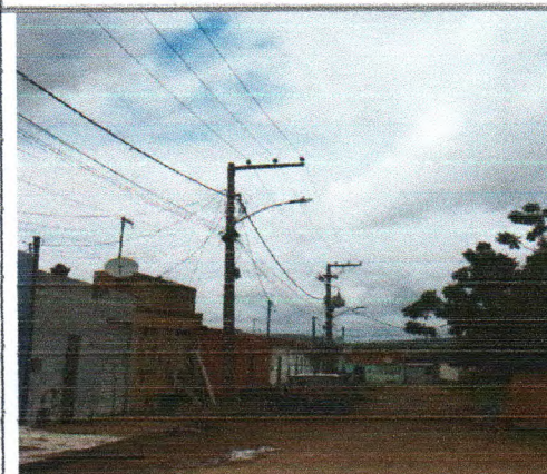
RUA H – TRECHO CONJUNTO FRANCISCO TELES DE MENDONÇA
