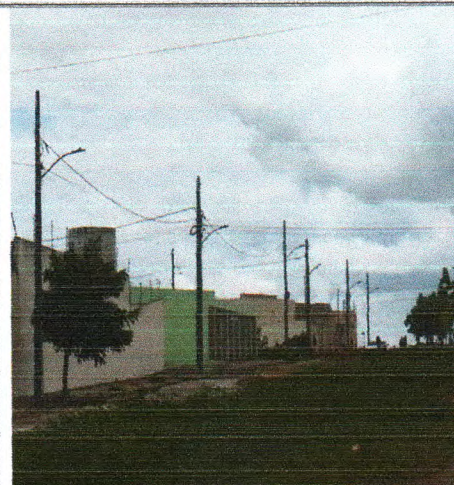
RUA H – TRECHO CONJUNTO FRANCISCO TELES DE MENDONÇA
