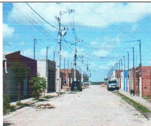
RUA NOEL JOSÉ DE SANTANA – RUA N
