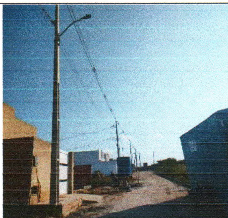
RUA PROJETADA Q (PRÓXIMO TRAVESSA SÃO LUIZ)
