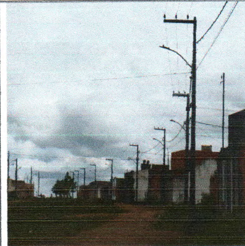
RUA H – TRECHO CONJUNTO FRANCISCO TELES DE MENDONÇA
