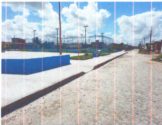
MEIO FIO; POSTES; PISO EM CONCRETO; RAMPAS PARA ACESSO DE DEFICIENTE
