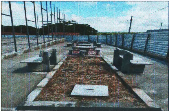
BANCO EM CONCRETO CANTEIRO 09
