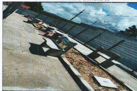
BANCO EM CONCRETO CANTEIRO 08
