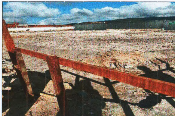
ATERRO CANTEIRO DE OBRA
