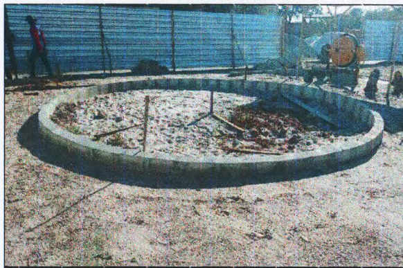
ASSENTAMENTO DE GUIA CANTEIRO 02
