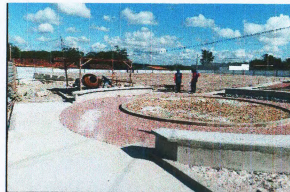
BANCO EM CONCRETO CANTEIRO 01
