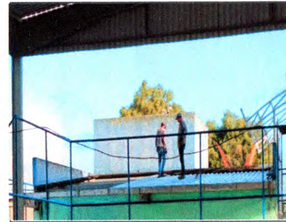
TELHAMENTO COM TELHA DE ALUMÍNIO- PALCO E VESTIÁRIOS
