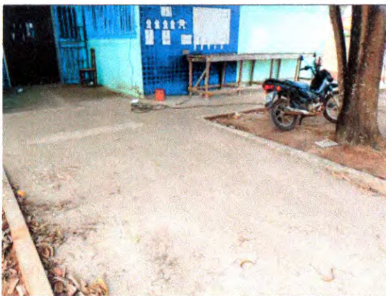
PISO EM CONCRETO
