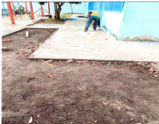
PISO EM CONCRETO
