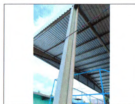
DRENAGEM- QUADRA COBERTA
