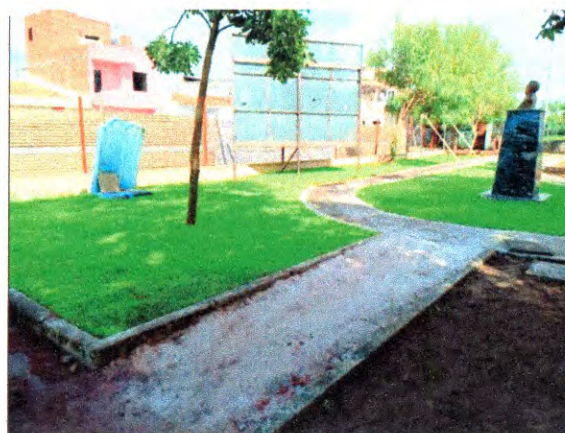
FORNECIMENTO E INSTALAÇÃO DE GRAMA
