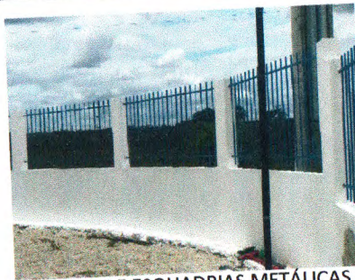
PINTURA DE ESQUADRIAS METÁLICAS - CIE
