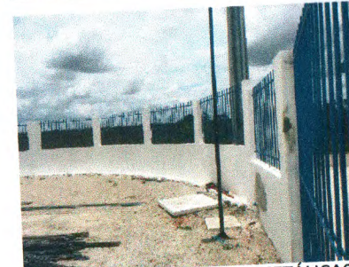
PINTURA DE ESQUADRIAS METÁLICAS - CIE
