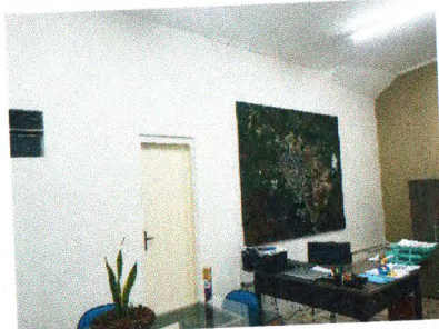
PINTURA DE PAREDES - SECRETARIA DE OBRAS
