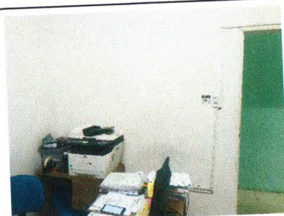
PINTURA DE PAREDES - SECRETARIA DE OBRAS
