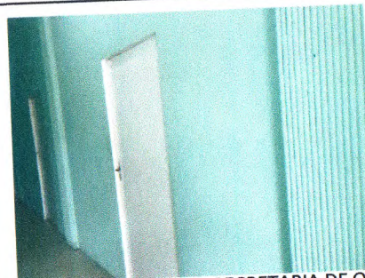
PINTURA DE PAREDES - SECRETARIA DE OBRAS
