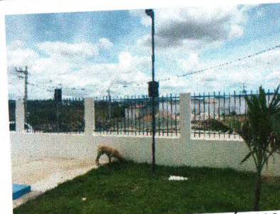
PINTURA DE ESQUADRIAS METÁLICAS - CIE
