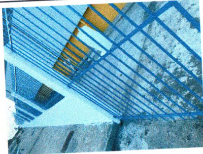
PINTURA DE ESQUADRIAS METÁLICAS E PISO EM CONCRETO - CIE
