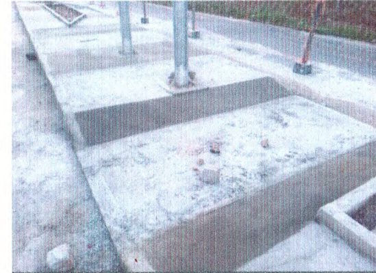
MEIO-FIO EM CONCRETO; RAMPA PARA ACESSO DE DEFICIENTE; PISO EM CONCRETO DESEMPOLADO
