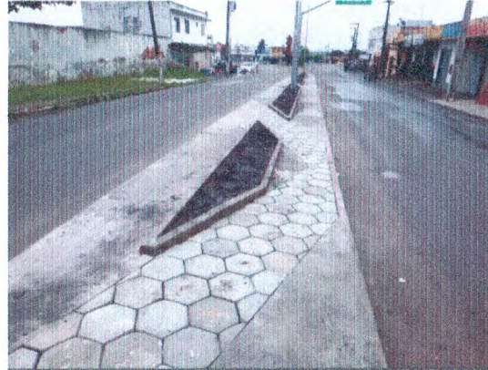
PISO DE BLOCO HEXAGONAL EM CONCRETO; MEIO-FIO E PISO EM CONCRETO DESEMPOLADO
