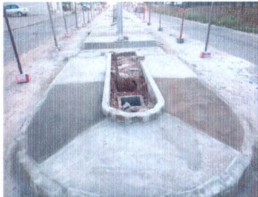
MEIO-FIO EM CONCRETO; CAIXA DE PASSAGEM; PISO EM CONCRETO DESEMPOLADO
