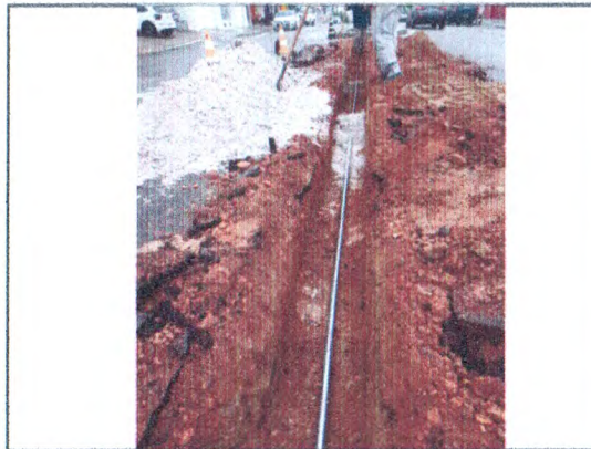
ESCAVAÇÃO; ELETRODUTO GALVANIZADO
