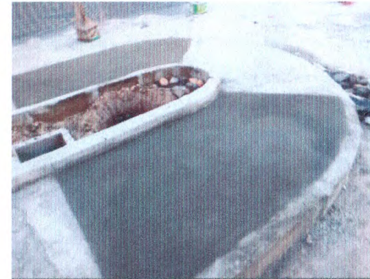
MEIO-FIO EM CONCRETO; CAIXA DE PASSAGEM; PISO EM CONCRETO DESEMPOLADO
