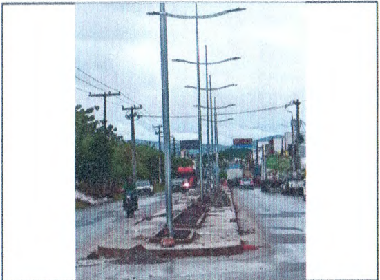
POSTES GALVANIZADOS E LUMINÁRIAS DE LED; MEIO-FIO E PISO EM CONCRETO DESEMPOLADO
