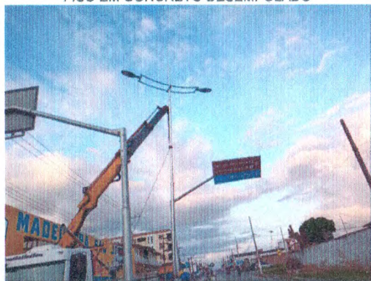
IMPLANTAÇÃO DE POSTE GALVANIZADO E LUMINÁRIAS DE LED
