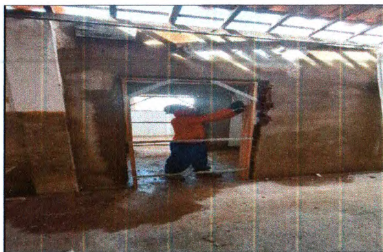
REMOÇÃO DE ESQUADRIAS
