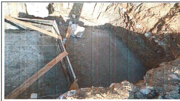
LOCAÇÃO DA OBRA
