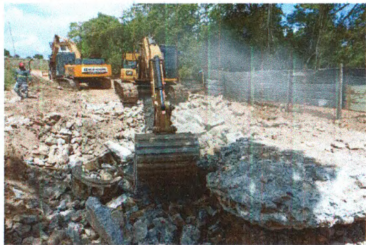
DEMOLIÇÃO E ESCAVAÇÃO MECANICA
