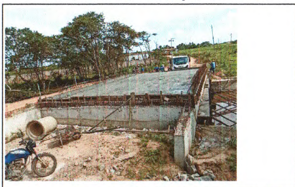
FORMA, ESCORAMENTO, AÇO, CONCRETO
