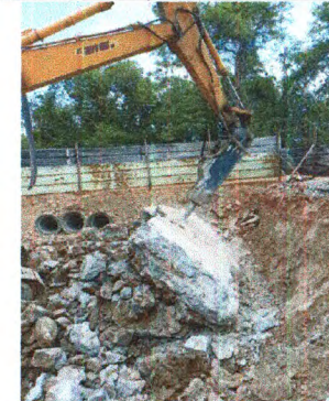
ESC. COM ROMPEDOR HIDRÁULICO - DEMOLIÇÃO
