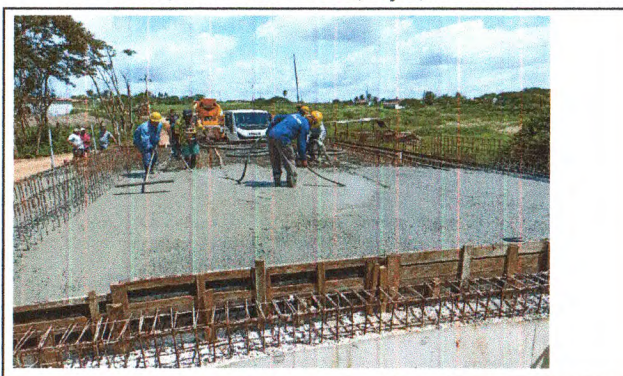
FORMA, ESCORAMENTO, AÇO, CONCRETO
