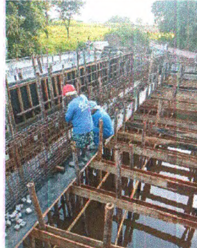
FORMA, AÇO E CONCRETO
