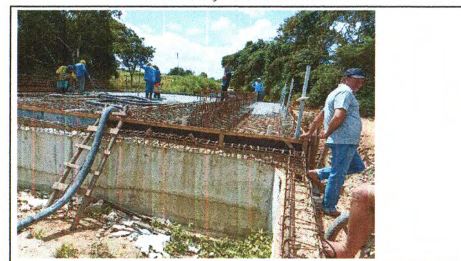
FORMA, ESCORAMENTO, AÇO, CONCRETO
