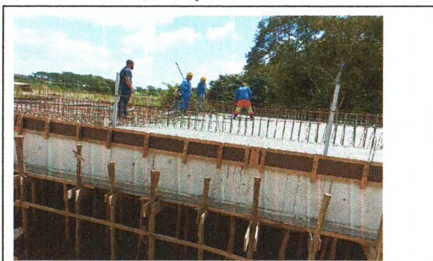
FORMA, ESCORAMENTO, AÇO, CONCRETO
