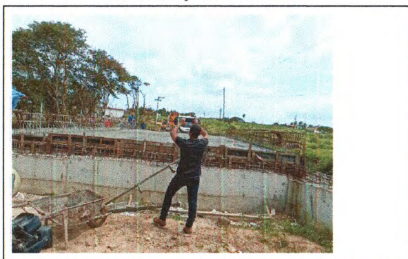
FORMA, ESCORAMENTO, AÇO, CONCRETO
