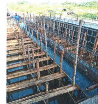
FORMA, AÇO E CONCRETO
