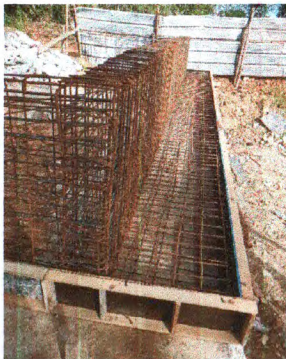
FORMA, AÇO E CONCRETO
