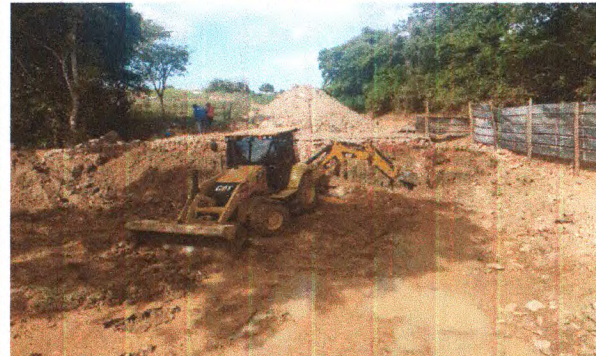
ESCAVAÇÃO MECANIZADA - MAT 2a CATEGORIA
