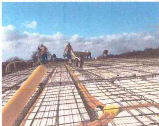
EXECUÇÃO DA LAJE DO BLOCO B; INSTALAÇÕES ELÉTRICAS
