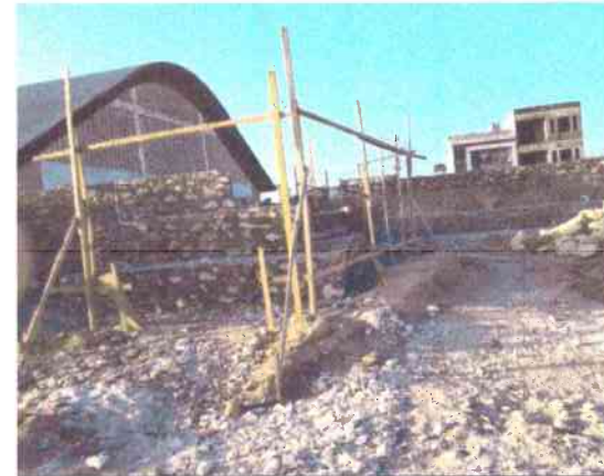
EXECUÇÃO DA ALVENARIA DE PEDRA;
