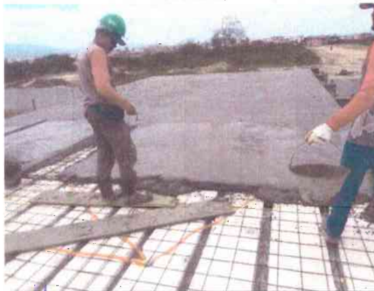
EXECUÇÃO DA LAJE DO BLOCO B;
