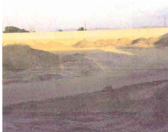
TERRAPLANAGEM E EXECUÇÃO DE SUB-BASE
