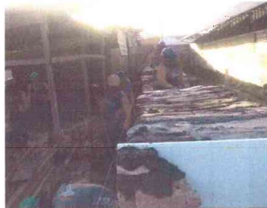
EXECUÇÃO DA ALVENARIA DE PEDRA PARA CONTENÇÃO DO MURO LATERAL
