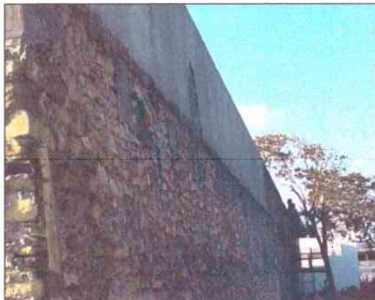
ALVENARIA DE PEDRA; ALVENARIA CERÂMICA; CHAPISCO; REBOCO NO MURO LATERAL
