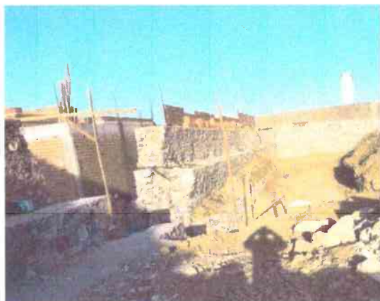
EXECUÇÃO DA ALVENARIA DE PEDRA; ALVENARIA CERÂMICA PARA MURO LATERAL
