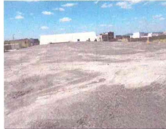
EXECUÇÃO DA LAJE DO BLOCO B;
