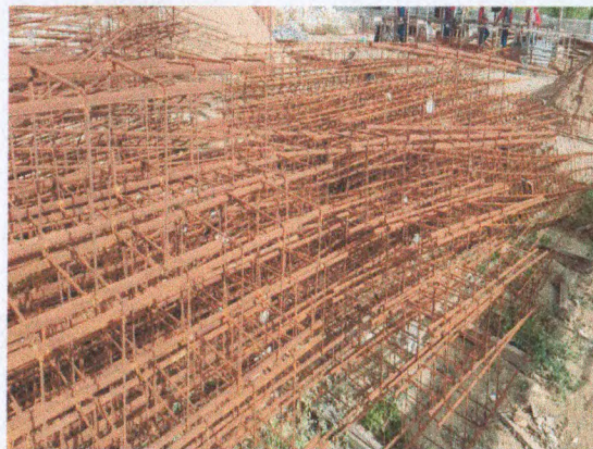
FERRAGEM DE PILARES
