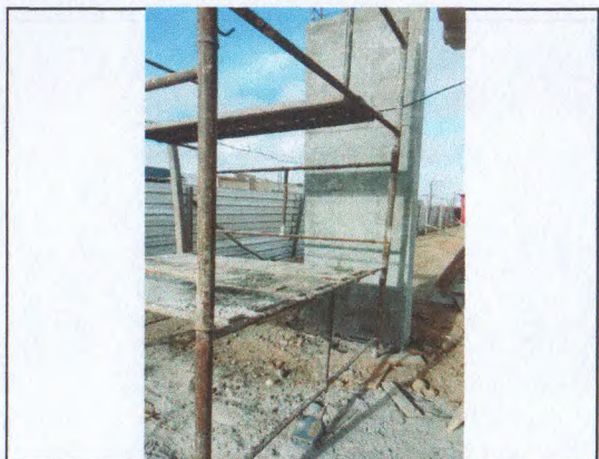
CONCRETO DE PILARES
