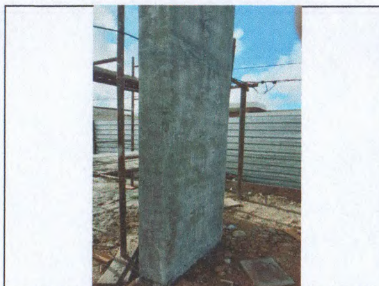
CONCRETO DE PILARES
