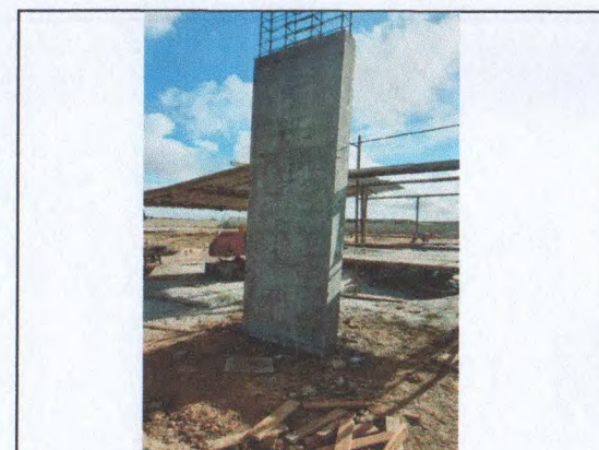
CONCRETO DE PILARES
