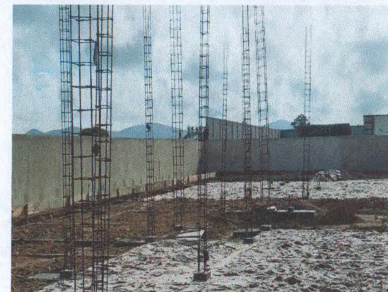
FERRAGEM DE PILARES
