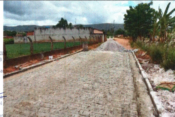
Foto 04: Conclusão da Pavimentação em paralelepípedo do trecho 02.
