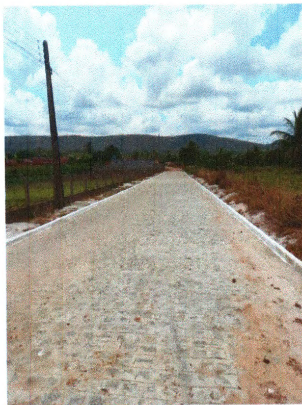
Foto 05 - Limpeza e Pintura de Meio-fio - Trecho 01
