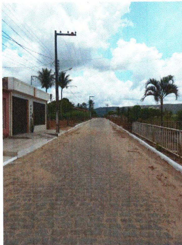
Foto 06 - Limpeza e Pintura de Meio-fio - Trecho 02
