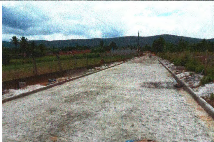
Foto 03: Pavimentação em paralelepípedo do trecho 02.
