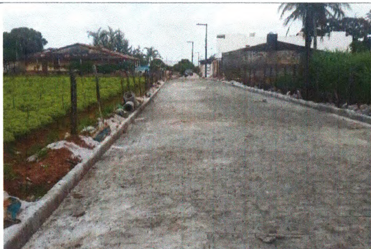
Foto 01: Pavimentação em paralelepípedo do trecho 01.
