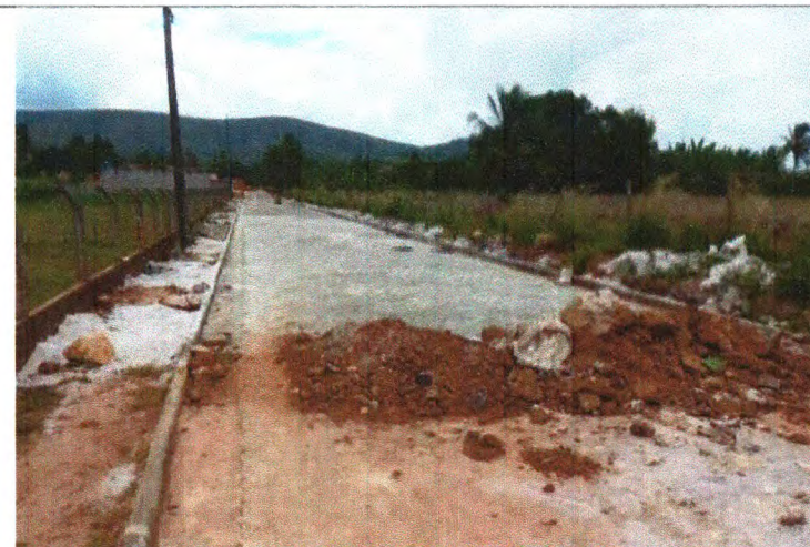
Foto 02: Pavimentação em paralelepípedo do trecho 02.
