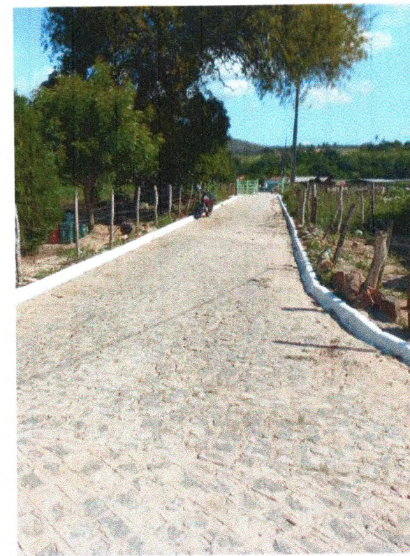
Foto 07 - Limpeza e Pintura de Meio-fio - Trecho 03
