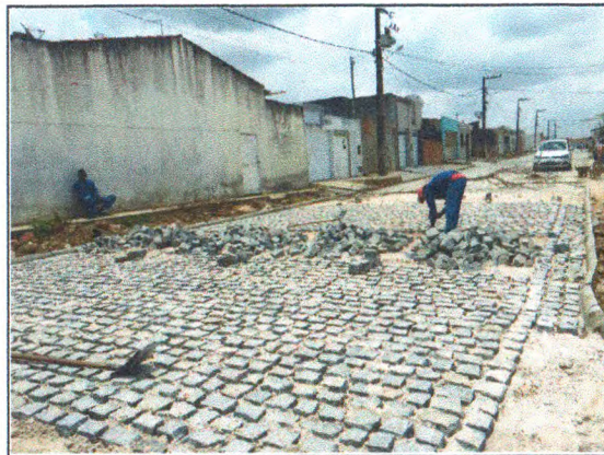
COLCHÃO DE AREIA, MEIO FIO E PARALELEPIPEDO NA RUA JOSIVAL NUNES DOS SANTOS
