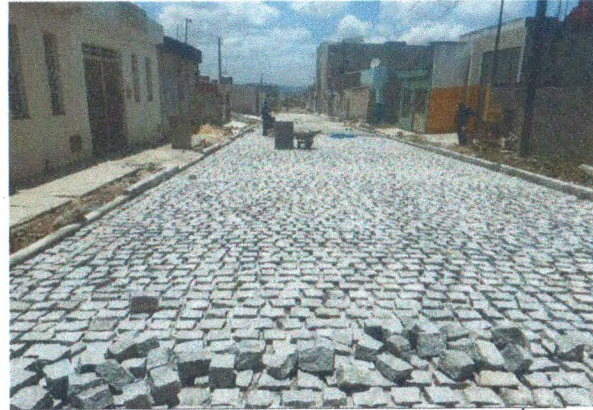
MEIO FIO E PARALELEPIPEDO NA RUA RUA JOSÉ ERALDO SANTOS
