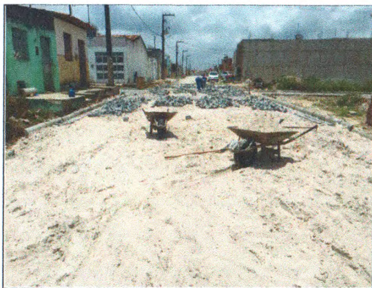
COLCHÃO DE AREIA, MEIO FIO E PARALELEPIPEDO NA RUA CARIOLANDO LIMA
