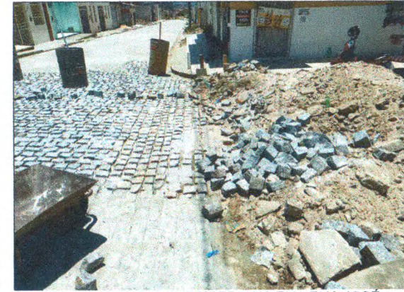
MEIO FIO E PARALELEPIPEDO NA RUA RUA JOSÉ ERALDO SANTOS
