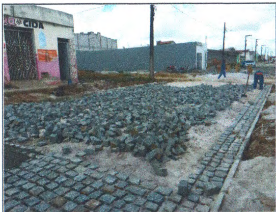
COLCHÃO DE AREIA, MEIO FIO E PARALELEPIPEDO NA RUA JOSIVAL NUNES DOS SANTOS
