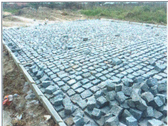
PAVIMENTAÇÃO NA RUA JOSIVAL NUNES DOS SANTOS
