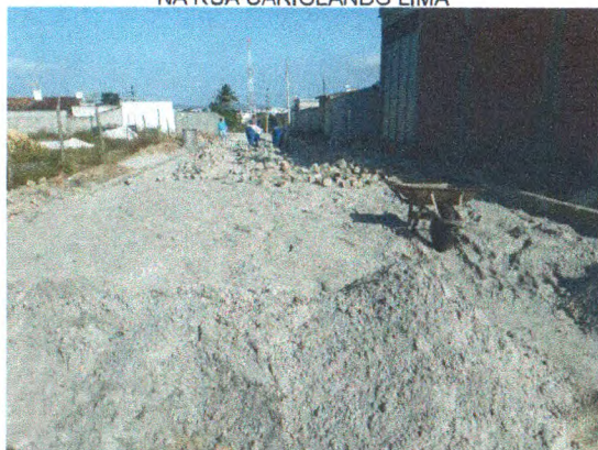
COLCHÃO DE AREIA, MEIO FIO E PARALELEPIPEDO NA TRV. PROJETADA 02
