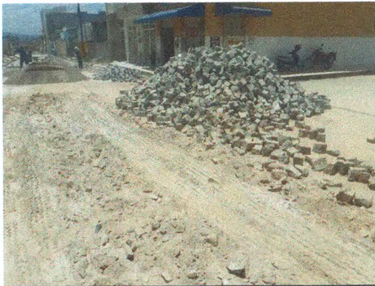
COLCHÃO DE AREIA, MEIO FIO E PARALELEPIPEDO NA RUA RUA JOSÉ ERALDO SANTOS
