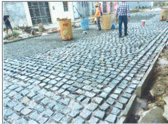
PAVIMENTAÇÃO NA RUA JOSIVAL NUNES DOS SANTOS
