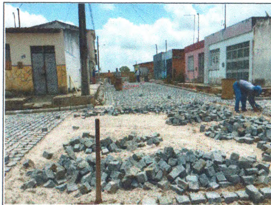
COLCHÃO DE AREIA, MEIO FIO E PARALELEPIPEDO NA RUA CARIOLANDO LIMA
