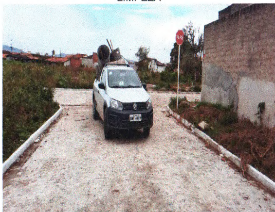
RUA QUINTINO DA SILVA NUNES - PLACA DE SINALIZAÇÃO; PINTURA DE MEIO-FIO E LIMPEZA
