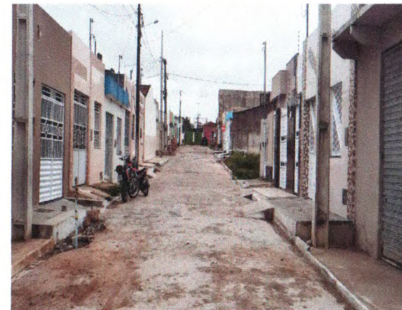
RUA JOSÉ LIMA - PINTURA DE MEIO-FIO E LIMPEZA
