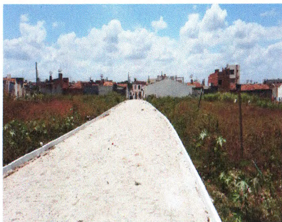
RUA PROJETADA "B" - PINTURA DE MEIO-FIO E LIMPEZA
