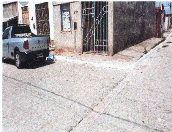
RUA JOSÉ VINCENTE DE ALMEIDA - PINTURA DE MEIO-FIO E LIMPEZA
