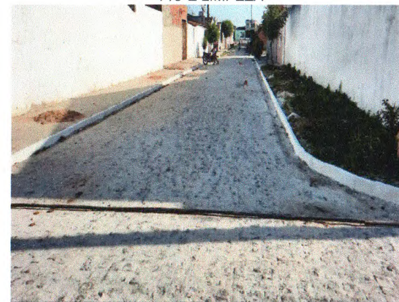
RUA FRANCISCA XAVIER NUNES - PINTURA DE MEIO-FIO E LIMPEZA
