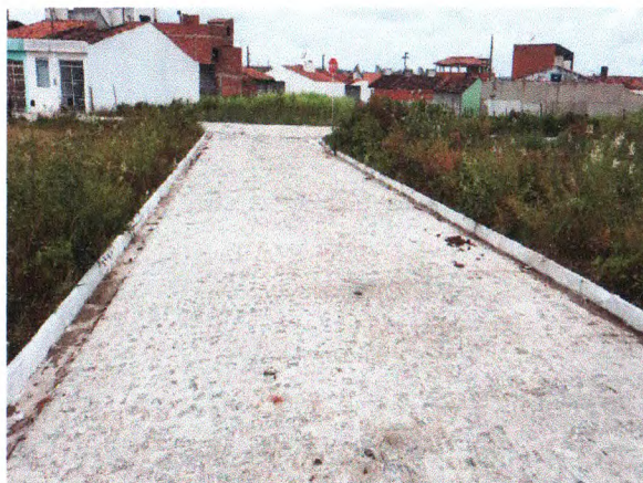
RUA QUINTINO DA SILVA NUNES - PLACA DE SINALIZAÇÃO; PINTURA DE MEIO-FIO E LIMPEZA
