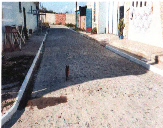
RUA FRANCISCA XAVIER NUNES - PINTURA DE MEIO-FIO E LIMPEZA
