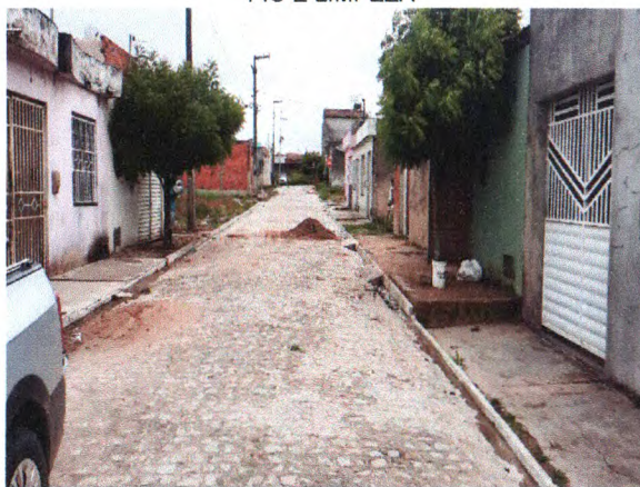
RUA JOSÉ DE SOUZA DANTAS - PINTURA DE MEIO-FIO E LIMPEZA
