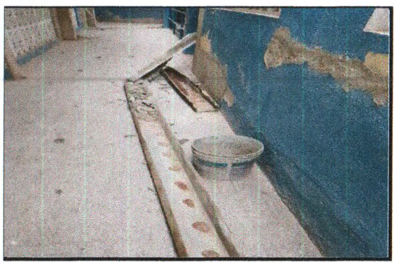
REMOÇÃO DE CALHA DE ZINCO
