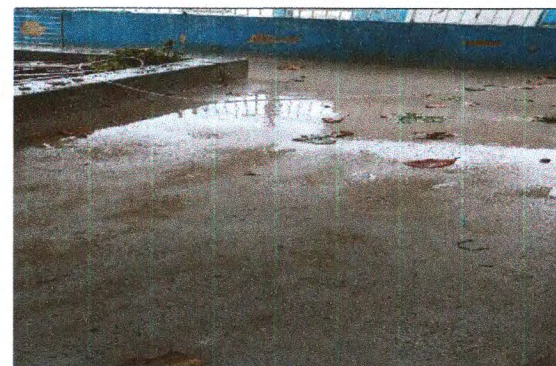
PISO EM CONCRETO
