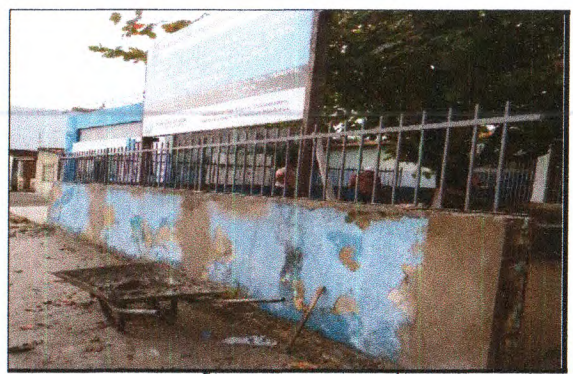
REMOÇÃO DE ESQUADRIA METÁLICA
