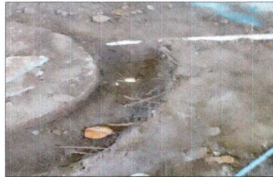
DEMOLIÇÃO MANUAL DE PISO
