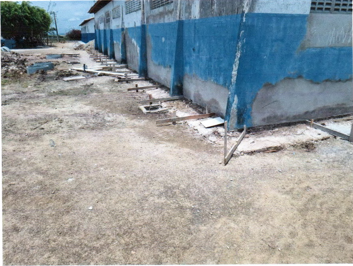
Fotos 14. Execução de passeio externo
