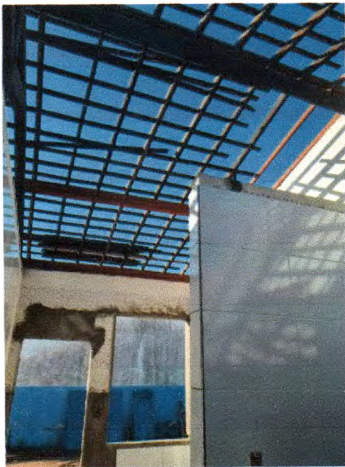
Fotos 04. Destelhamento dos vestiários para limpeza das telhas; remoção e substituição do madeiramento do telhado; remoção de esquadrias; execução de revestimento; instalação de vergas.
