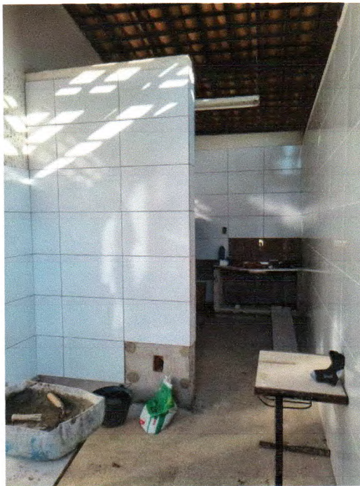
Fotos 07. Execução de revestimento em espaço no vestiário; remoção de revestimento, esquadrias e acessórios nos vestiários
