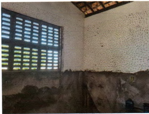
Fotos 13. Preparação de parede para instalação de revestimento; chapisco e reboco em paredes externas
