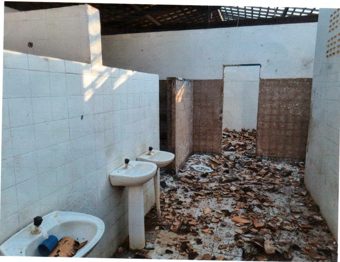
Fotos 08. Remoção de revestimentos
