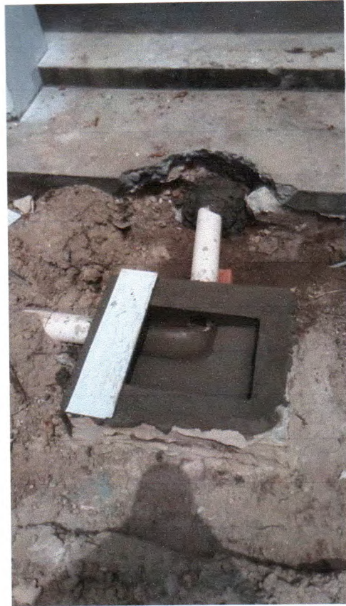
Fotos 12. Execução de caixas de passagem
