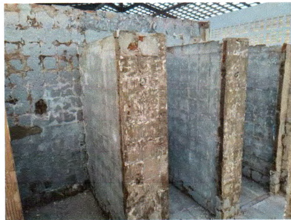
Fotos 07. Execução de revestimento em espaço no vestiário; remoção de revestimento, esquadrias e acessórios nos vestiários
