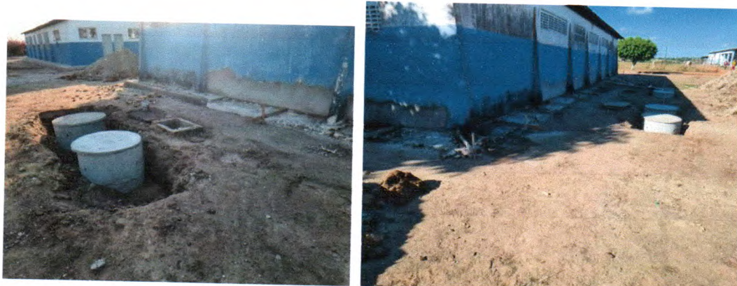
Fotos 09. Execução das fossas
