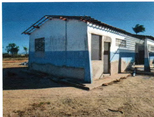
Fotos 05. Destelhamento dos vestiários para limpeza das telhas; remoção e substituição do madeiramento do telhado; remoção de esquadrias; reboco e chapisco em paredes; execução de passeio externo
