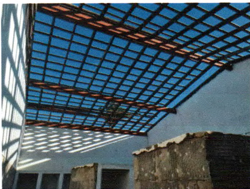
Fotos 05. Destelhamento dos vestiários para limpeza das telhas; remoção e substituição do madeiramento do telhado; remoção de esquadrias; reboco e chapisco em paredes; execução de passeio externo
