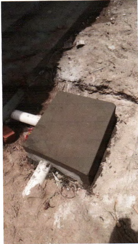
Fotos 12. Execução de caixas de passagem
