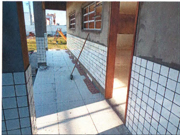
ESQUADRIAS; REVESTIMENTO CERÂMICO DO PISO E PAREDES
