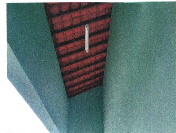
LUMINÁRIA; PINTURA INTERNA
