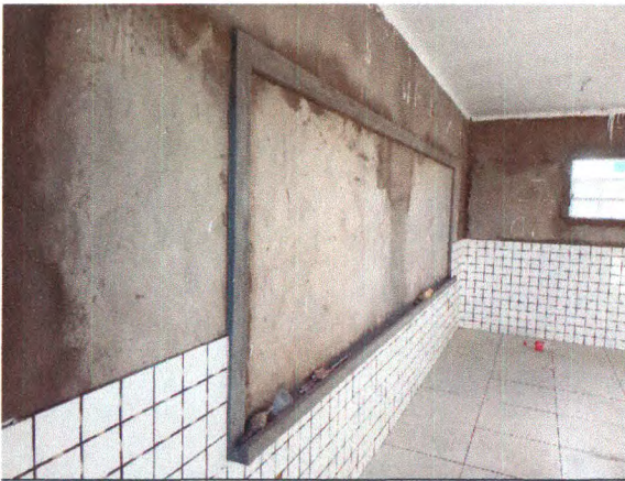
FORRO DE GÊSSO; ESQUADRIAS; REVESTIMENTO CERÂMICO DO PISO E PAREDES; QUADRO ESCOLAR
