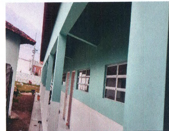
ESQUADRIAS; VIDROS; REVESTIMENTO CERÂMICO; PINTURA EXTERNA
