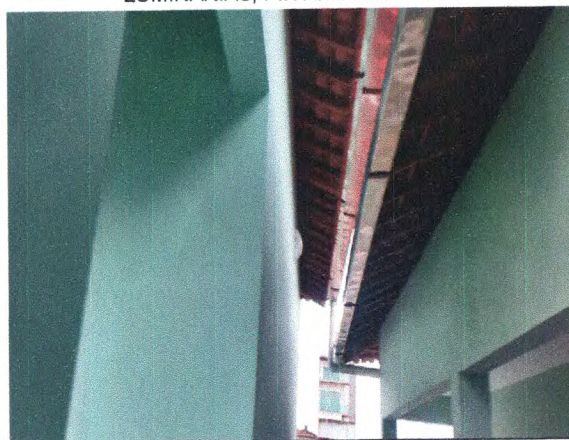
CALHA METÁLICA; PINTURA EXTERNA
