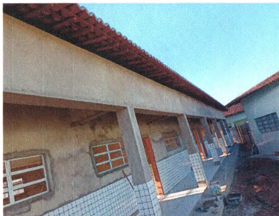
EMASSAMENTO DE BEIRAL; ESQUADRIAS; REVESTIMENTO CERÂMICO DO PISO E PAREDES
