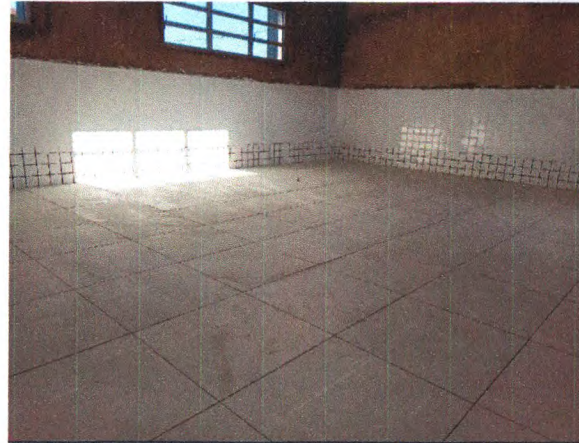
ESQUADRIAS; REVESTIMENTO CERÂMICO DO PISO E PAREDES
