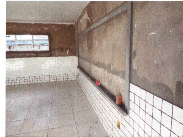
FORRO DE GÊSSO; ESQUADRIAS; REVESTIMENTO CERÂMICO DO PISO E PAREDES; QUADRO ESCOLAR
