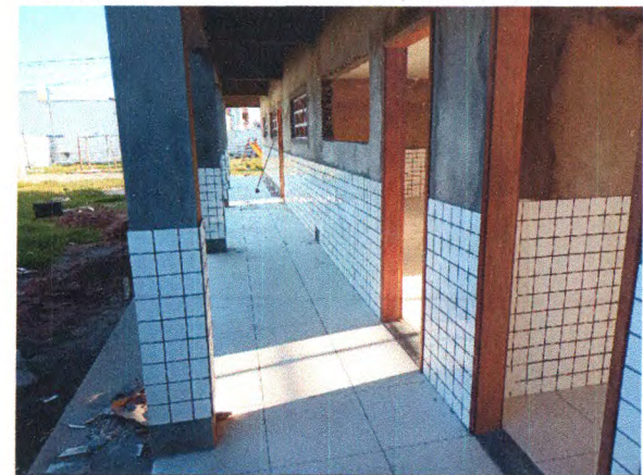
ESQUADRIAS; REVESTIMENTO CERÂMICO DO PISO E PAREDES
