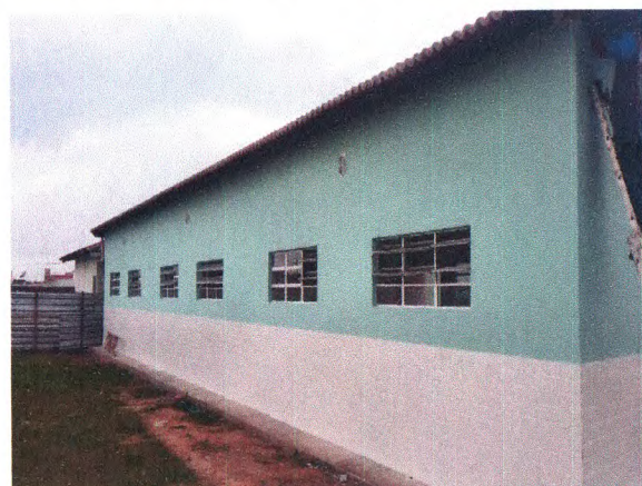
ESQUADRIAS; VIDROS; REVESTIMENTO CERÂMICO; LUMINÁRIAS; PINTURA EXTERNA; CALÇADA EM CONCRETO
