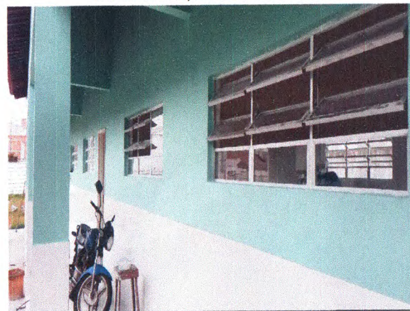
ESQUADRIAS; VIDROS; REVESTIMENTO CERÂMICO; PINTURA
