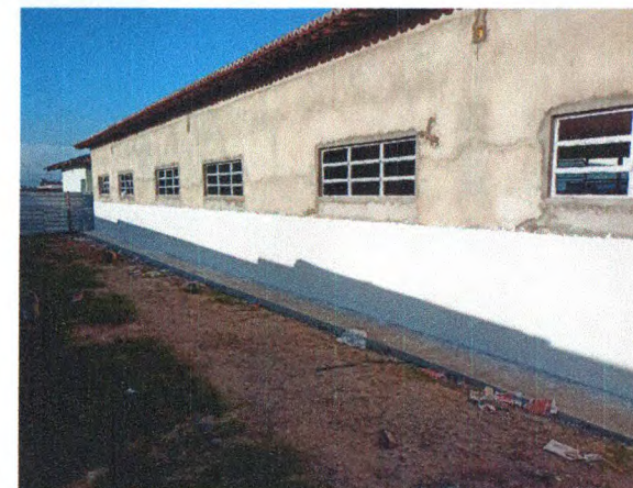
EMASSAMENTO DE BEIRAL; ESQUADRIAS; REVESTIMENTO CERÂMICO DAS PAREDES
