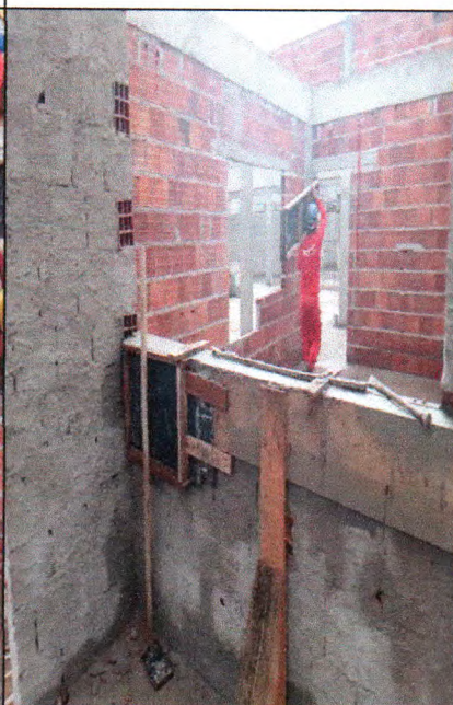
Figura 05 : Cintas e Vergas em concreto armado pré-moldado fck=15 mpa, seção 9x12cm
