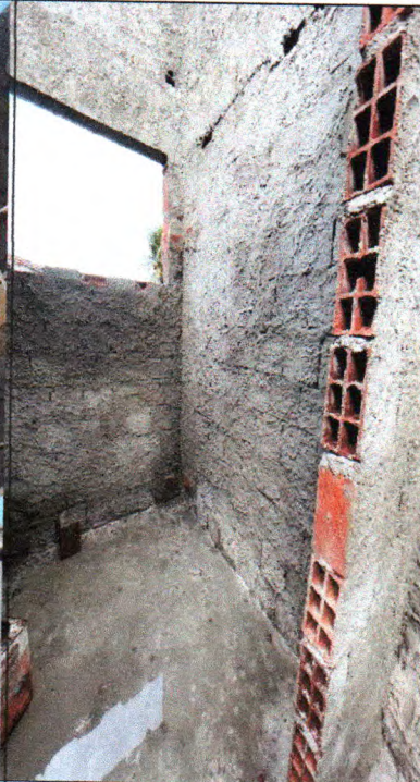
Figura 10 : Emboço, para recebimento de cerâmica
