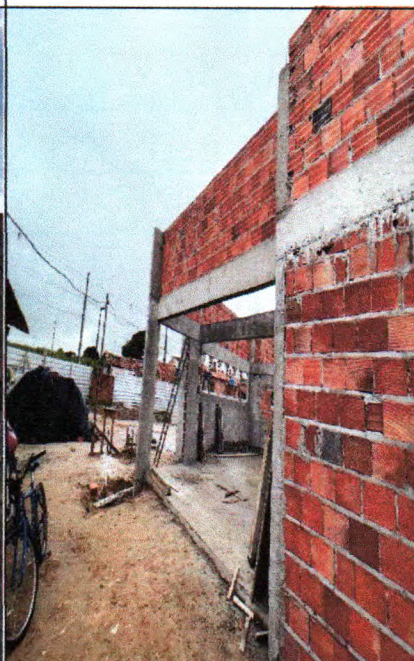
Figura 05 : Cintas e Vergas em concreto armado pré-moldado fck=15 mpa, seção 9x12cm
