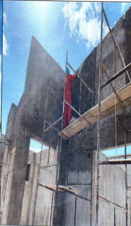
Figura 12 : Reboco interno de parede
