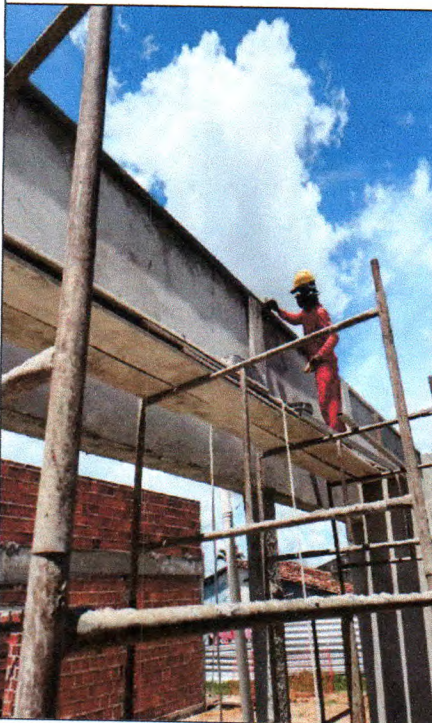
Figura 11 : Reboco ou emboço externo, de parede
