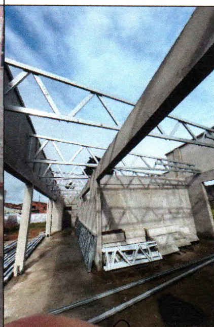
Figura 06 : Estrutura Metálica p/Cobertura c/ Vigas - Treliça
