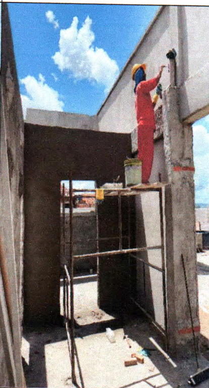
Figura 12 : Reboco interno de parede
