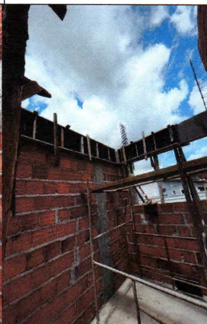
Figura 06 : Estrutura Metálica p/Cobertura c/ Vigas - Treliça
