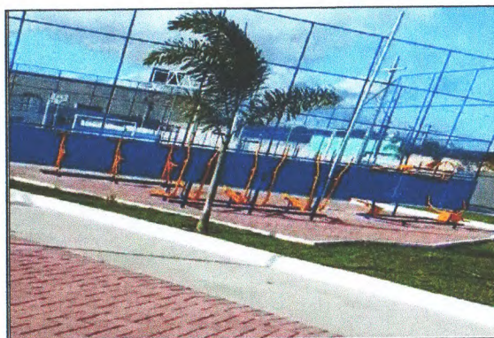
Pintura dos equipamentos
