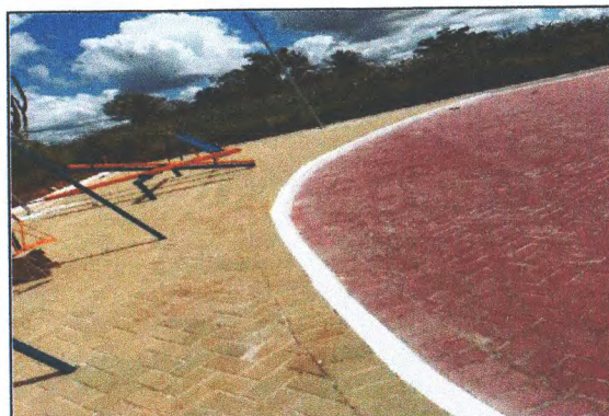
Pintura dos equipamentos
