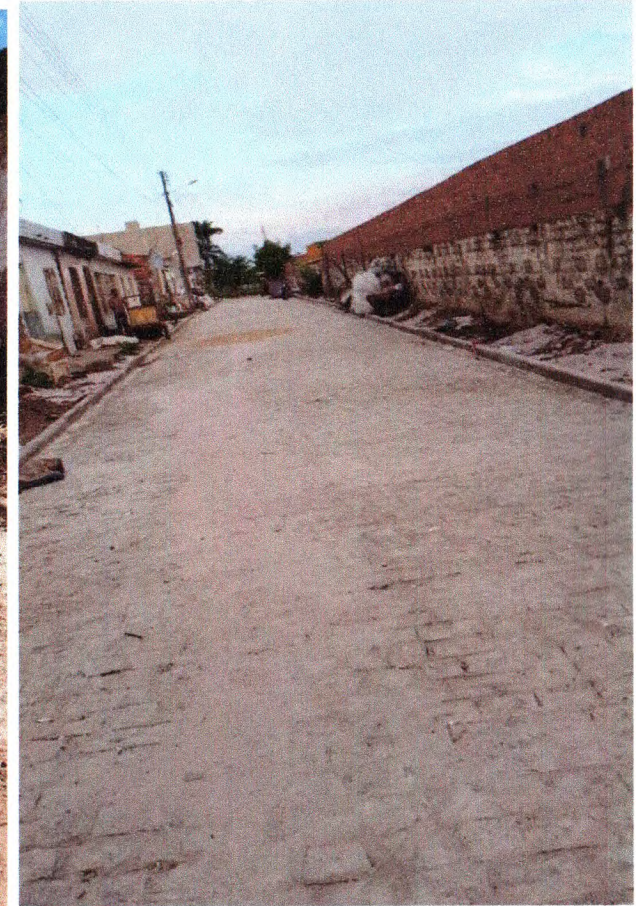
Pavimentação Rua Antônio Menezes
