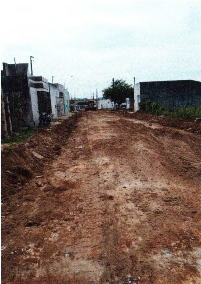
Regularização da Rua Minervina dos Santos
