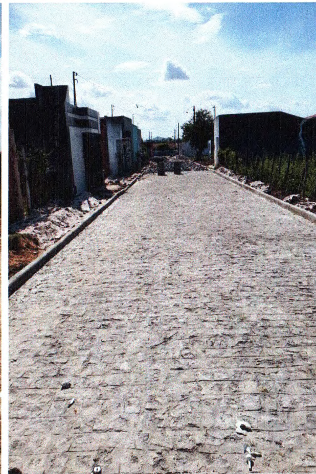
Pavimentação da Rua Minervina dos Santos
