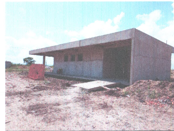
ADMINISTRAÇÃO - ESTRUTURA; ELEVAÇÃO; CHAPISCO E REBOCO
