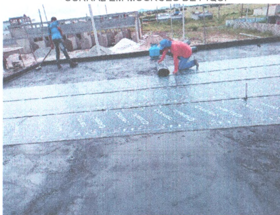
ADMINISTRAÇÃO - IMPERMEABILIZAÇÃO COM MANTA ASFÁLTICA
