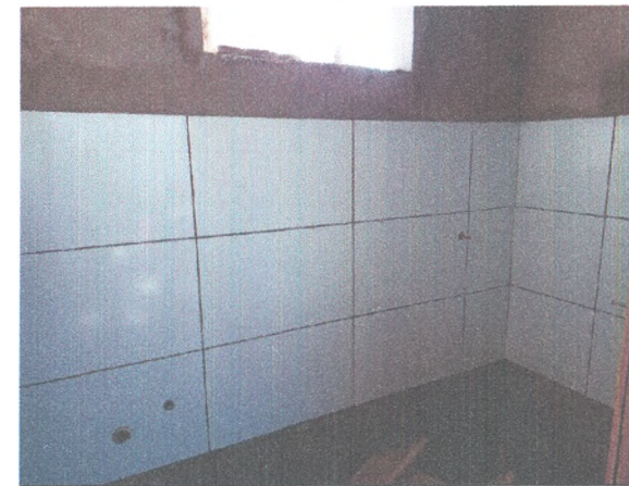
ADMINISTRAÇÃO - REVESTIMENTO CERÂMICO
