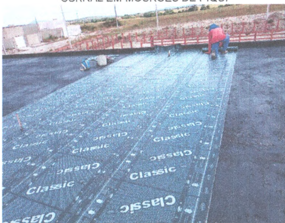
ADMINISTRAÇÃO - IMPERMEABILIZAÇÃO COM MANTA ASFÁLTICA
