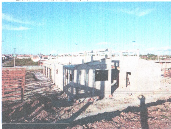
BAIAS COBERTAS - ESTRUTURA; ELEVAÇÃO; CHAPISCO E REBOCO
