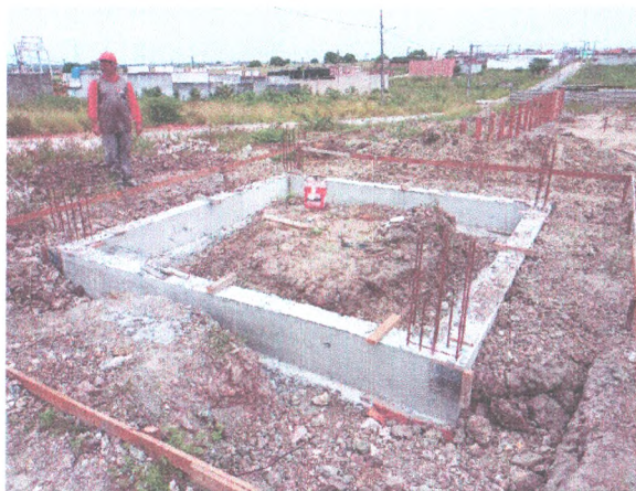
RESERVATÓRIO ELEVADO - FUNDAÇÃO EM CONCRETO ARMADO
