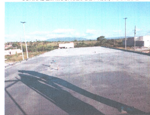
ADMINISTRAÇÃO - PROTEÇÃO MECANICA DA IMPERMEABILIZAÇÃO DA LAJE; ILUMINAÇÃO EXTERNA - POSTES DE CONCRETO E LUMINÁRIAS 04 PÉTALAS EM LED
