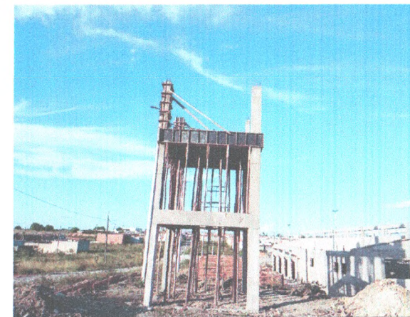
RESERVATÓRIO ELEVADO - ESTRUTURA EM CONCRETO ARMADO
