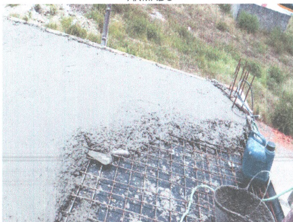
RESERVATÓRIO ELEVADO - CONCRETAGEM DA LAJE
