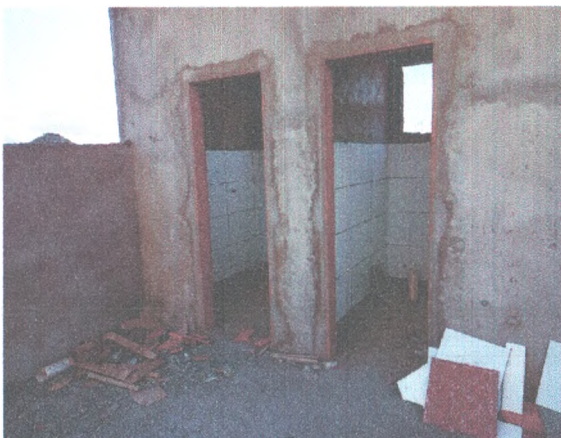
BAIAS COBERTAS - CAIXÃO DAS PORTAS; CHAPISCO; REBOCO; REVESTIMENTO CERÂMICO
