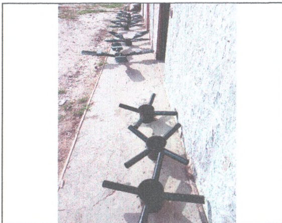
MONTAGEM DAS LUMINÁRIAS EXTERNAS
