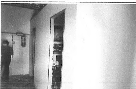
EXECUÇÃO DE PAREDE EM BLOCO DE GESSO
