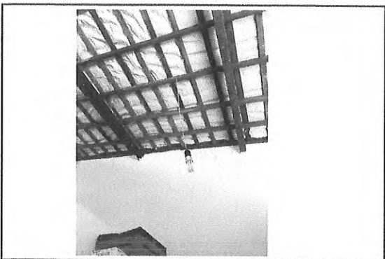
INSTALAÇÃO DE PONTO DE LUZ
